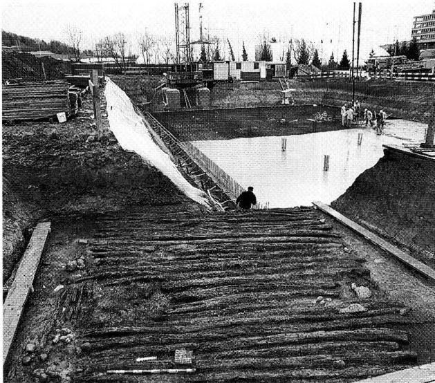
Abb. 21. Otelfingen ZH, Lautet. Der Prügelweg aus Erlen- und Eschenstämmen. Blick nach Osten in Richtung des Strassenverlaufs.
