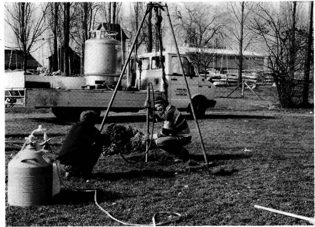
Abb. 14. Zug-Seeufergestaltung. Gefrierkern-Bohrung: Einrammen des Bohrgestänges mit einem Presslufthammer. Das Kühlen des Rohres geschieht mit Flüssigstickstoff aus dem im Vordergrund sichtbaren mobilen Druckgefäss, das beim grossen Tank auf dem Fahrzeug jeweils wieder aufgefüllt werden kann. Das Ziehen des gekühlten Bohrrohres erfolgt anschliessend mit Flaschenzug und Dreibein.
