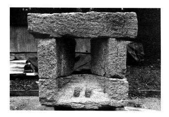
Fig. 16. Avenches VD, Insula 7. Les éléments en grès coquillier de la lucarne du bâtiment central remontés; dimensions de l'ouverture extérieure:  $53 \times 21$  cm.  $3^{\rm e}$  s. ap.J.-C.
