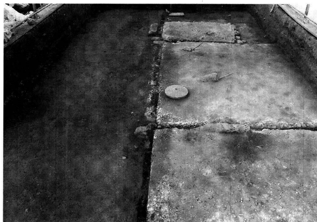
Fig. 20. Lausanne VD, Lousonna-Vidy , propriété Sagrave. Sols de mortier et cloisons de bois et de terre se rattachant à un état non maçonné (vue sud).
