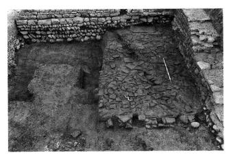
Fig. 9. Insula 7. Vestiges d'un des sols de terre battue de la première domus flavienne. A noter le revêtement grossier de fragments de tegulae entourant un seuil de molasse et, au premier plan, le bas de cloison à colombage.
