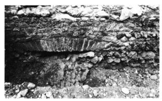
Fig. 10. Le mur sud du portique ou corridor M présente un dispositif de décharge à l'endroit où il croise le tracé du collecteur nord-sud: sur un pont de planches, dont les traces subsistent dans le mortier, a été disposée une rangée de claveaux de tuf surmontés d'une assise de briques.
