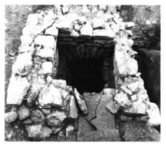
Fig. 8. Vue d'un regard du collecteur nord-sud. On distingue les deux ressauts qui servaient de support au panneau ou à la trappe de fermeture.
