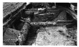
Fig. 7. La jonction des égoûts au sud du chantier; vue du sud. a l'égoût nord-sud suit son cours vers le sud; b l'égoût ouest-est observé en 1986 suit la pente naturelle du terrain en direction du mur de soutènement de la terrasse; c une troisième canalisation se jette obliquement dans la voûte du collecteur.
