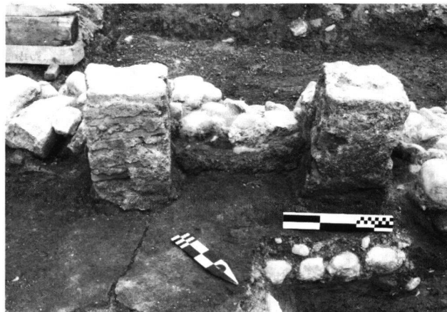
Fig. 4. Avenches VD, Derrière la Tour (1987). Vestiges de pilettes d'hypocauste construites à l'aide d'un coffrage de fragments de tegulae noyés dans un mortier de tuileau. Deuxième moitié 1er siècle apr. J.-C.
