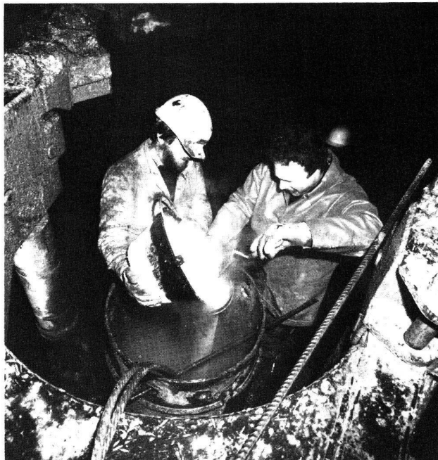
Abb. 2. Das Trockeneis wird in das Sondierrohr eingefüllt.
