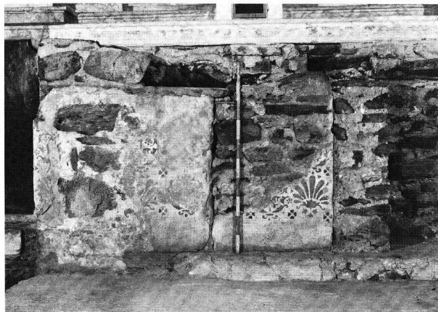
Fig. 11. Bioggio, Oratorio di San Ilario. L'altar maggiore come si presenta in una fase di ricerca; si riconoscono quattro fasi di ingrandimento ed il gradino ottocentesco che accompagna l'attuale tabernacolo. Di particolare interesse il resto della decorazione pittorica collocabile sul finire del XIV secolo.
