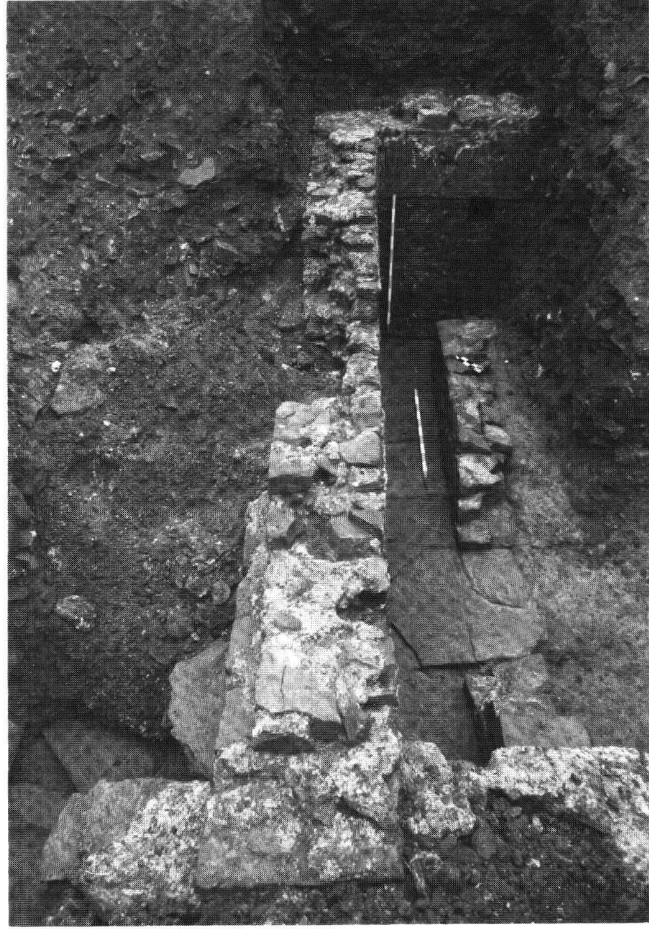
Fig. 6. Montreux-Baugy VD 1987. Annexe orientale. Vue de la canalisation aménagée dans les soubassements d'un avant-corps.
