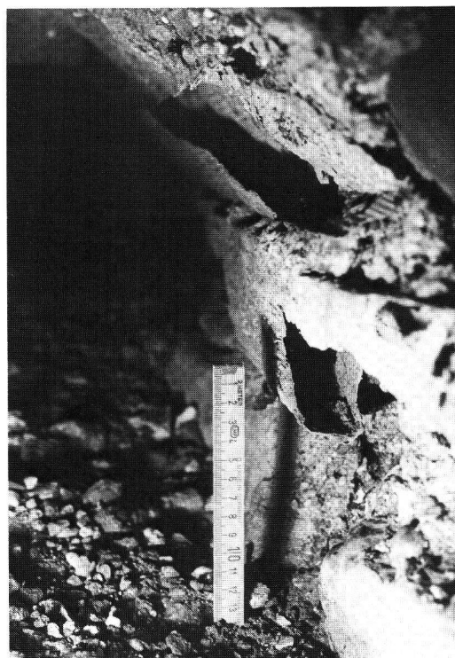
Fig. 10. Empreinte en tuf de deux planchettes du cintre de construction de la voûte.
