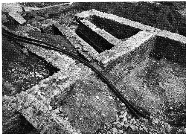
Fig. 13. Vue des locaux A et B, du sud-ouest. On aperçoit dans le couloir de service le ressaut qui marque le niveau de circulation à l'intérieur.
