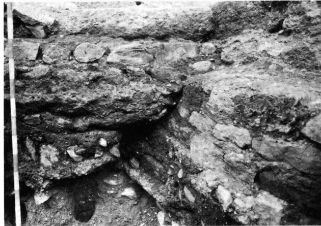
Fig. 4. Vue du raccord entre le seuil et la tour Nord après l'enlèvement de la couverture. Négatifs correspondant aux pieux de fondation. (Photo IAHA).
