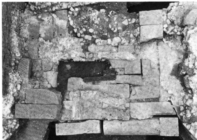
Fig. 3. Seuil de la porte de l'Est. A gauche en bas, large semelle de fondation supportant le seuil. A droite, deux blocs, dont une couverte de mur de tranche semi-circulaire, prennent appui sur le ressaut de fondation de la tour Nord. (Photo IAHA).
