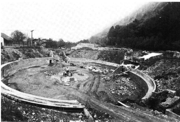
Fig. 57. Martigny VS. Amphithéâtre. L'avancement des travaux. Vue prise du sud-ouest, en novembre 1983.
