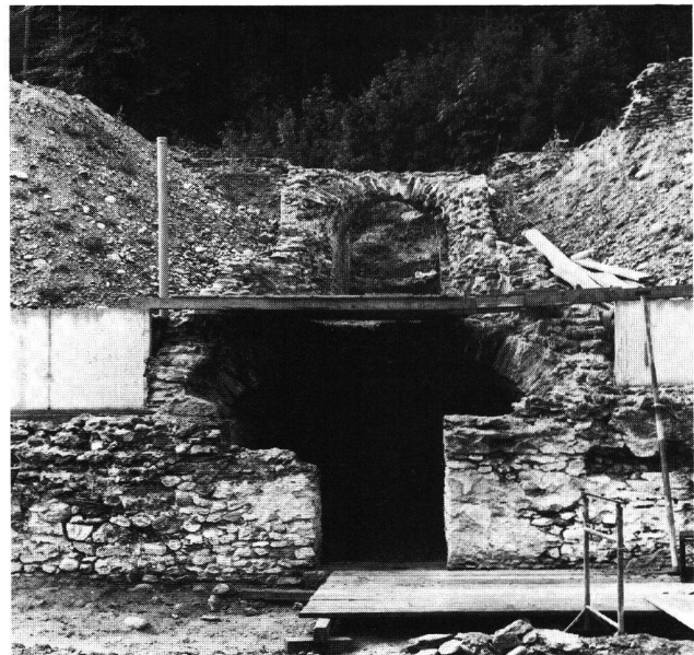
Fig. 58. Martigny VS. Amphithéâtre. Le carcer sud-est, ouvert sur l'arène, surmonté de la tribune des autorités (ou pulvinar), prolongée par un couloir voûté, du nord-ouest.
