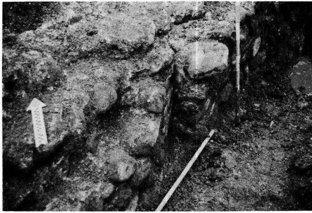
Fig. 55. Nyon VD, La Morache. Bâtiment B: réfection avec trace d'un étiayage dans le mur sud de S2 (fig. 52, 3).
