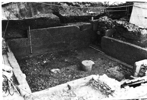
Fig. 39. Crissier VD, Montassé. Villa romaine. Vue de la cave en molasse pendant la fouille. (Photo: F. Francillon.)
