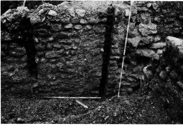
Fig. 53. Nyon VD, La Morache. Bâtiment B: mur ouest de S1, traces de poutres (fig. 52, 1).
