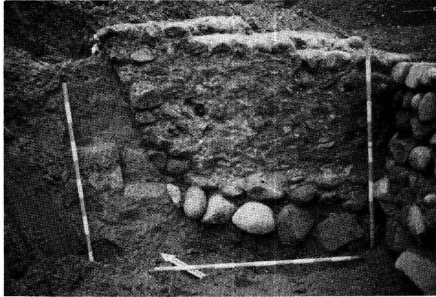
Fig. 56. Nyon VD, La Morache. Bâtiment B: fondation du mur est de S3, appuyé contre le talus (fig. 52, 4).
