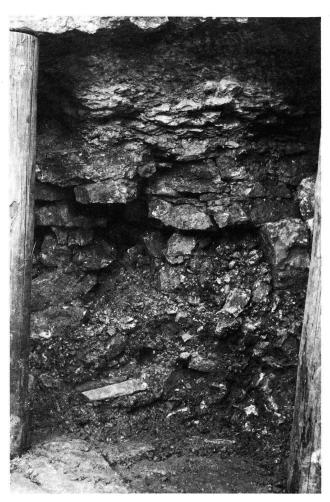
Abb. 11. Pleigne JU, Löwenburg. Zentralplatz, Ausweitung West: Teil des Untertagebaus («Weitung») mit der heutigen Sicherung durch Holzstempel. Der Bergbauschutt in der unteren Hälfte gibt die Höhe des alten Abbaus an.
