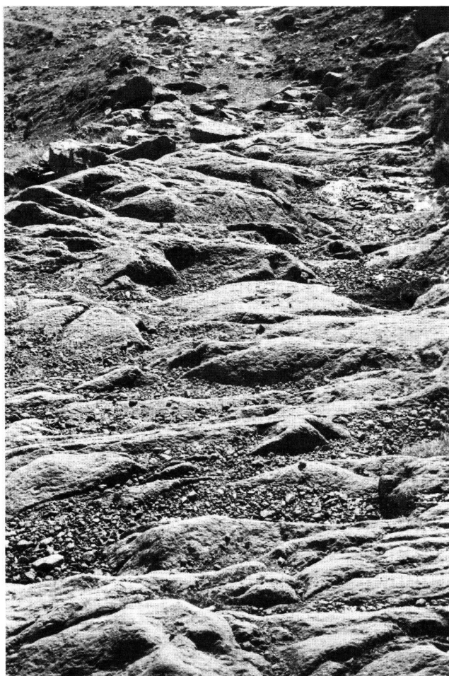
Abb. 10a. «Neuer» Weg von 1552 passwärts von Mot (Koord. 799 375/140 600). Blick talwärts gegen Süden. Der Weg ist z.T. aus dem Felsen gehauen und, wo das nicht der Fall ist, gepflästert. Im Siegfried-Atlas, Section 7, Blatt XX, 1887 heisst diese Stelle wegen einer angeschnittenen Gletschermühle Buco da la Pignata.
