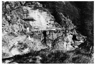
Abb. 18. Blick gegen Osten auf die Schlüsselstelle des neuzeitlichen Weges am Sassegl. Die ältere Wegvariante führte steil über den Felsen hinweg. Dort, wo der hier sichtbare Weg vom Fels in den Hang übergeht, hat sich dieser im Laufe von ca. 100 Jahren um 40 cm gesenkt.
