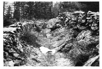
Abb. 14. Alter Tal- und Passweg nordwestl. des Hofes Ruini di Zarera. Da er Wiesen quert, ist er beidseits von hohen Mauern begleitet. Bei diesem Wegabschnitt muss es sich nicht um eine neuzeitliche Anlage (wie in Abb. 13) handeln, da ja der neue Weg nur von Angeli Custodi bis hieher gebaut werden musste.
