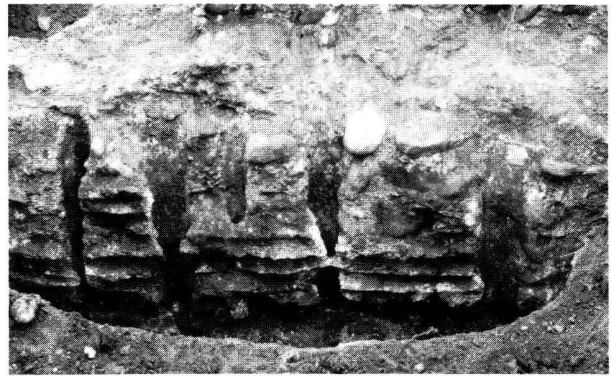
Abb. 4. Südwanne der Südmauer (bei der Südostecke) mit Abdrücken von horizontalen Rundhölzern und mit Löchern von senkrechten Pfählen der Holzverschalung einer während der Bauarbeiten einsturzgefährdeten Partie der südlichen Fundamentgrubenwand. Aufgenommen anlässlich der Ausgrabung 1923.
