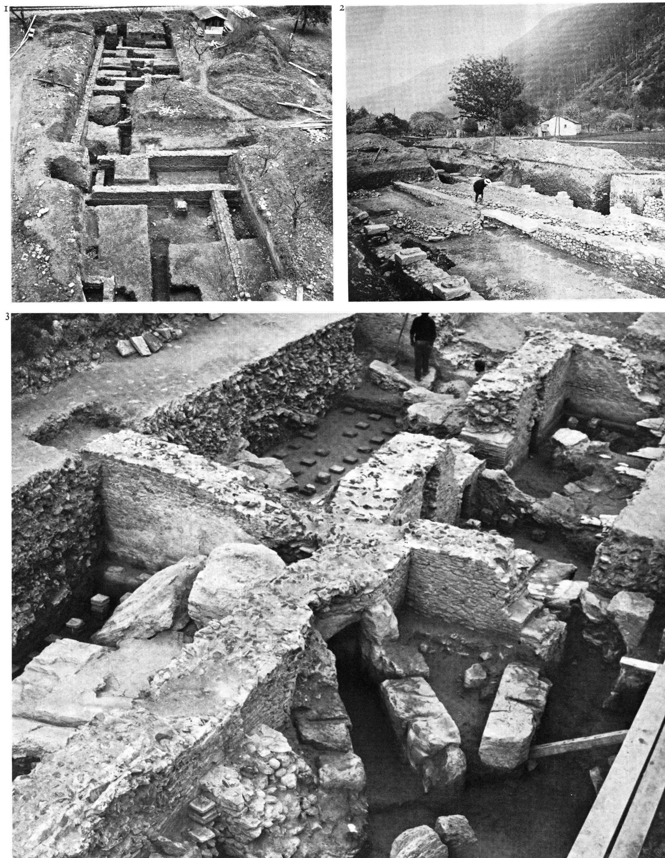
Pl. 44. Martigny VS. Forum Claudii Vallensium. 1 En Pré Borvey, fouilles 1973. Le chantier, vu du nord-ouest; 2 Fouilles 1908. La double colonnade. Vue de l'ouest. A l'arrière-plan, les maisons sont
