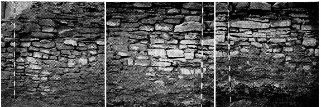
Tafel 30 B. Filzbach GL, Voremwald. Detailaufnahmen der Nordmauer (S. 151).
