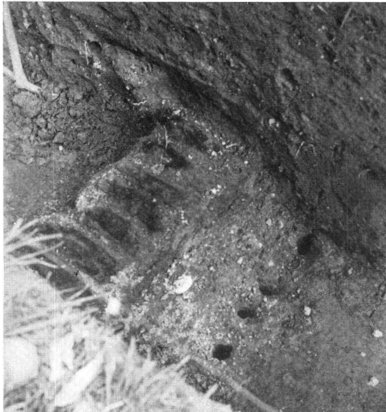
Taf. XIV, Abb. 1. Nürens Dorf-Engelrain Balkenlage im römischen Straßenkastell (S. 118)
