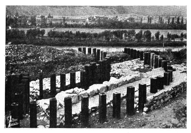
Fig. 25. Wallmauer östlich vom Lagertor, mit dem erneuerten Pfahlwerk.
