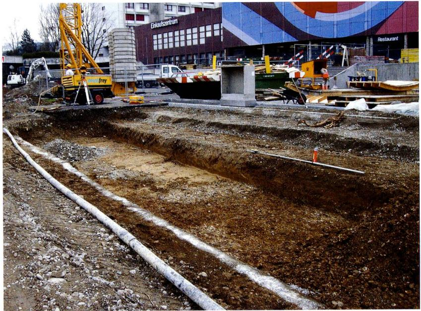
Abb. 68: Kaiseraugst AG, Liebrüti Vorplatz (Baubegleitung 2012.004). Am südlichen Ende der Baustelle wurde ein etwa 7 m x 7 m grosser Schacht ausgehoben. Die Baugrubenböschungen zeigten sterilen, ockerfarbenen Lehm. Blick von Nordosten.
