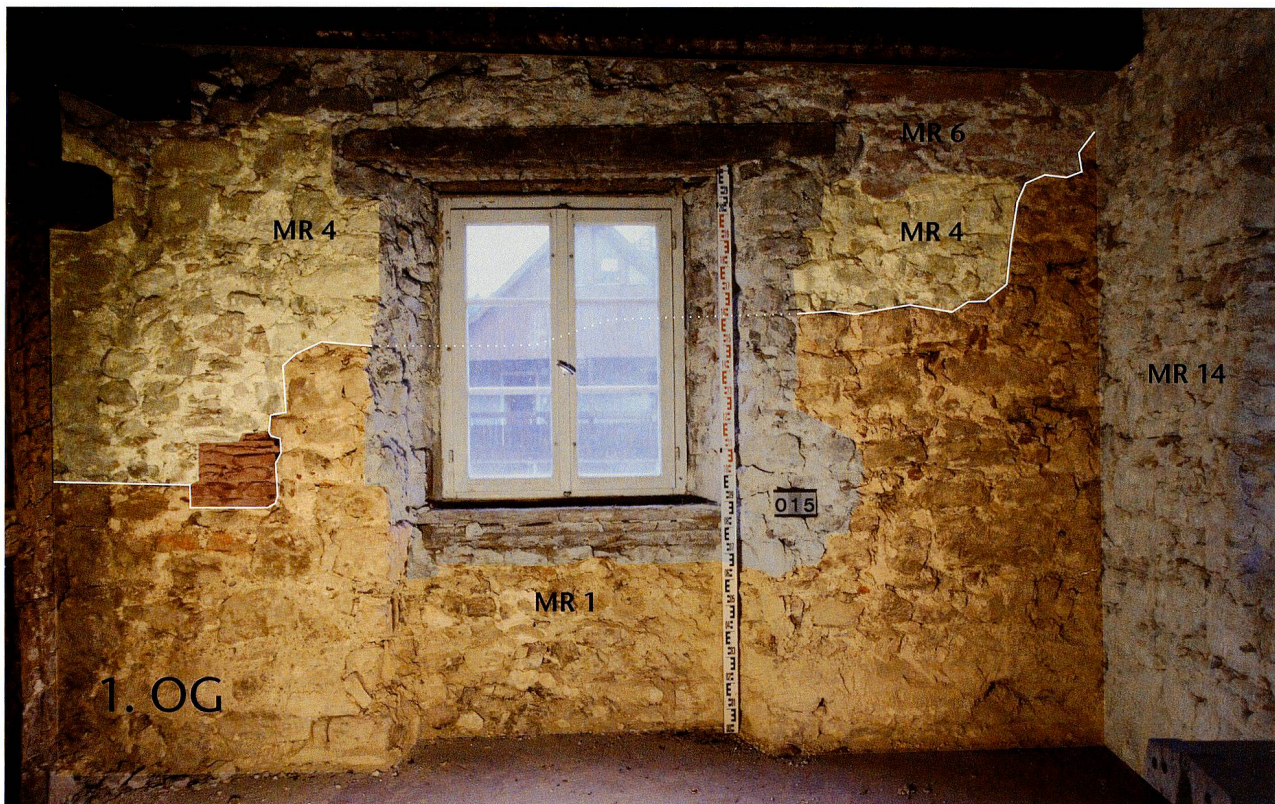
Abb. 67: Kaiseraugst AG, Umbauten Kirchgasse Haus 4 (Bauuntersuchung 2011.013). Westfassade 1. Obergeschoss. Hochmittelalterliche Umfassungsmauer und neuzeitliche Einbauten.
