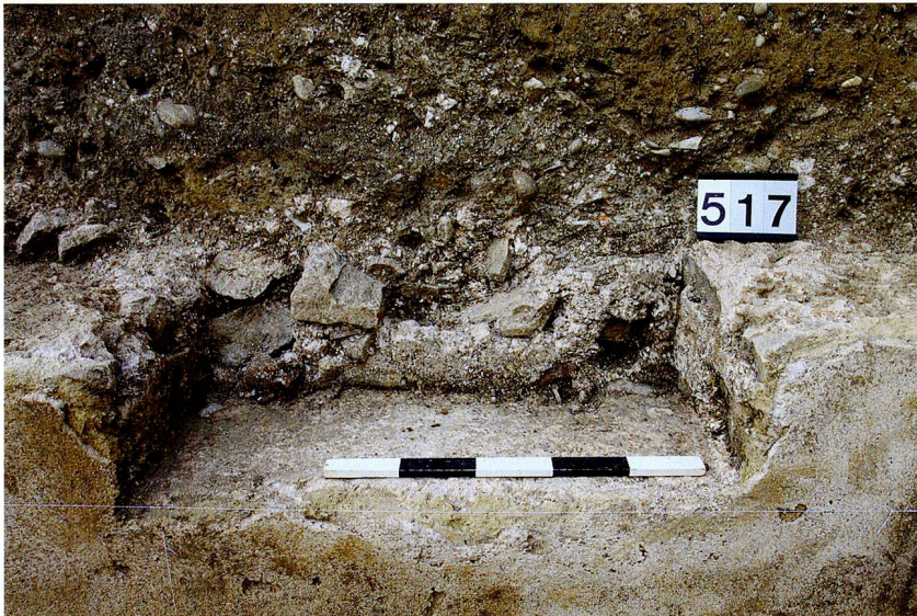
Abb. 20: Kaiseraugst AG, Auf der Wacht (Grabung 2011.001). Rechteckige Aussparung in MR 34 des unterirdischen Raums. Die noch in situ liegenden Nägel und Spuren im Mörtel bezeugen, dass einst ein Holzschrank oder -regal eingebaut gewesen war. Blick von Nordwesten.
