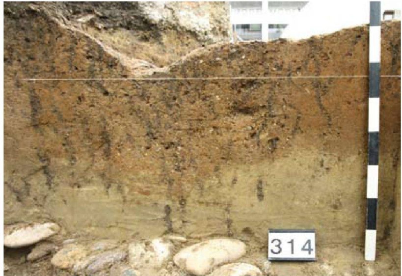
► Abb. 8: Kaiseraugst AG, Autoeinstellhalle Löwen (Grabung 2010.001). Möglicher Teuchel-leitungsgraben im Profil.
