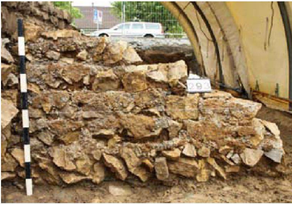
Abb. 6: Kaiseraugst AG, Autoeinstellhalle Löwen (Grabung 2010.001). Ansicht von Süden auf das Fundament von MR 16. Im unteren Bereich sind schräggestellte, trocken gesetzte Kalksteine. Darüber sind fünf Lagen Kalksteine in Mörtel zu erkennen.
