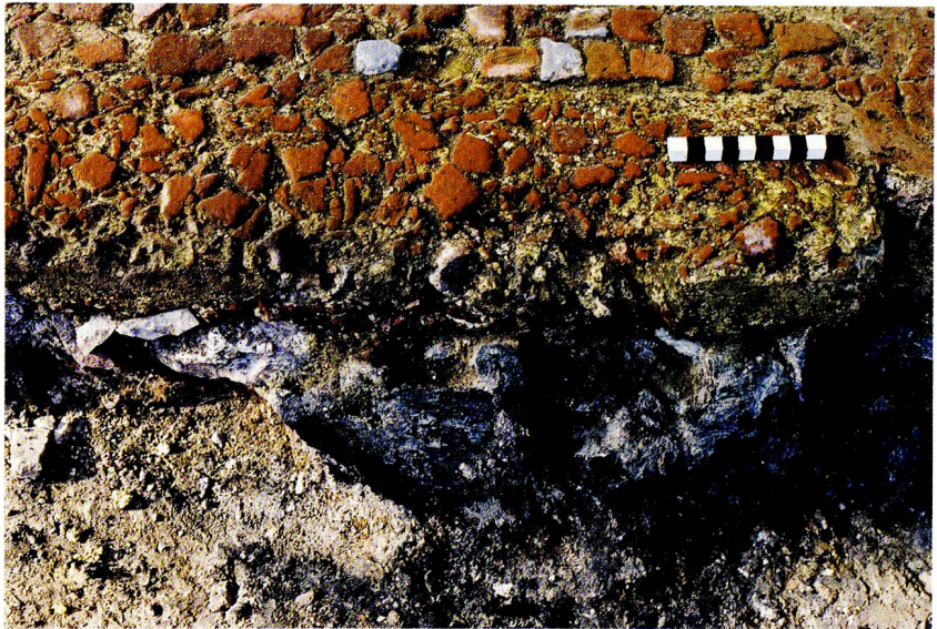
Abb. 9: Augusta Raurica, Region 2A westlich des Theaters. Abgenutzte Türschwelle (links in der Verlängerung des Massstabs) mit Negativabdruck des Türpfostens (rechts, angeschnitten).
