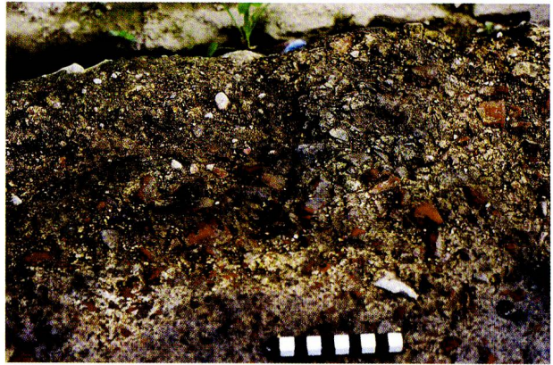
Abb. 26: Augusta Raurica, Region 2A westlich des Theaters. Grossflächiger Bröckelzerfall.
