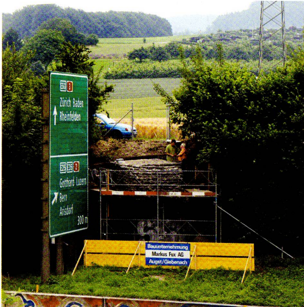
Abb. 36: Augst BL, Sanierung Stadtmauer West (Grabung 2008.062). Der von Gerüsten und einem Schutzzaun umgebene Stadtmauerrest während der Sanierung. Vorne angeschnitten die Autobahn. Von Nordwesten.
