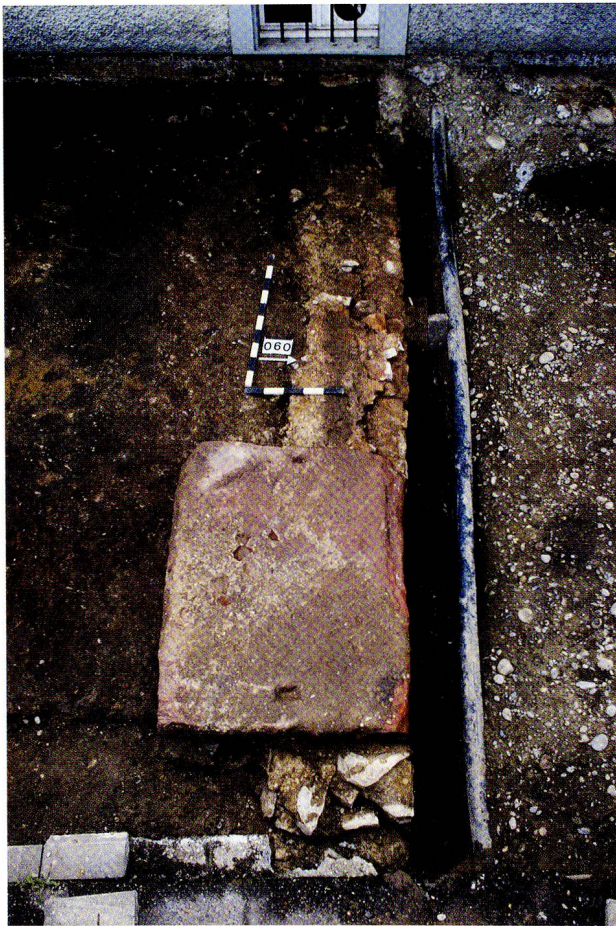
Abb. 30: Augst BL, Degen Zufahrtsstrasse (Grabung 2008.057). Aufsicht auf die Portikusmauer MR 1. Rechts anschliessend die Fläche der Rauricastrasse, links die Gehfläche der Portikus. Der Strassengraben ist durch eine Leitung gestört. Von Osten und oben.
