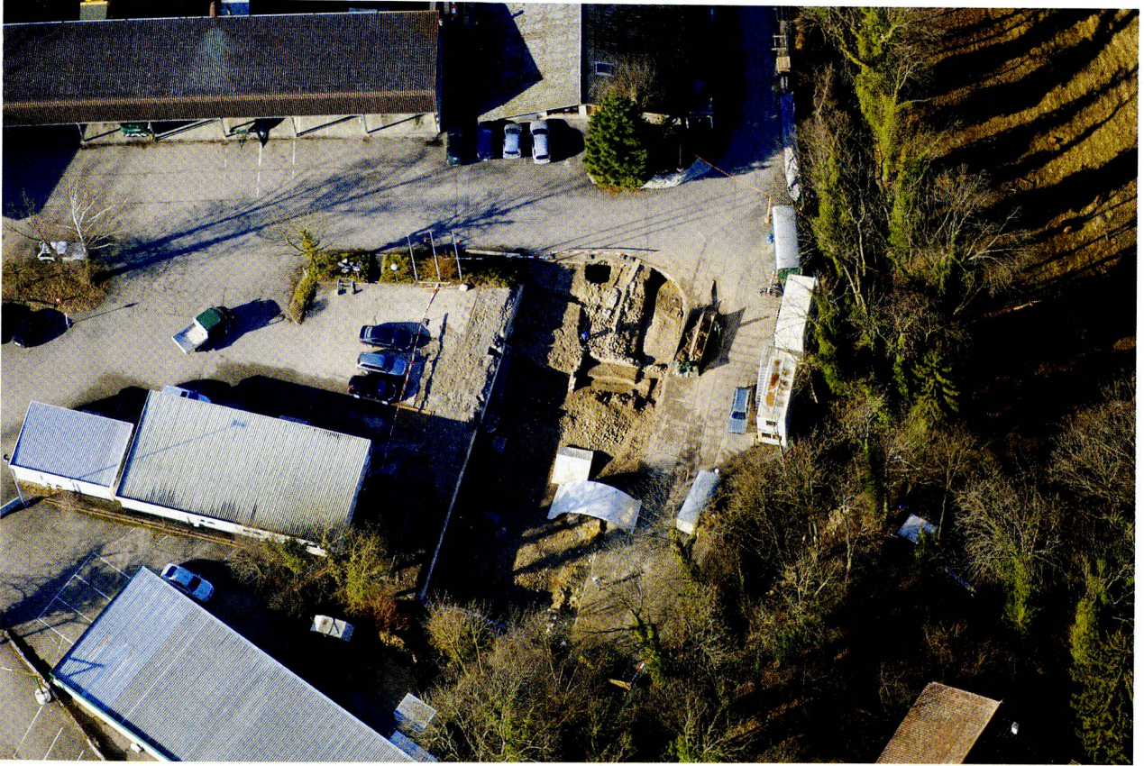
Abb. 38: Augst BL, Luftbildprospektion (Aktennummer 2008.088). Das Areal der Grabung 2008.051 im Werkhof der E. Frey AG (siehe oben S. 122–128). Die dabei teilweise freigelegte Fielenriedstrasse verläuft etwa in der Mitte des Bildes von unten nach oben, rechts davon zeichnen sich innerhalb der Grabung die Reste der östlichen Strassenrandbebauung ab. Rechts zwischen den Bäumen der Violenbach. Norden ist oben.
