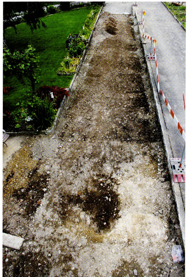
Abb. 28: Augst BL, Degen Zufahrtsstrasse (Grabung 2008.057). Blick von Süden, das heisst von Region 9D her gegen Norden. Im Vordergrund der gereinigte Teil der Rauricastrasse, die quer zum Bild von rechts nach links verläuft. Rechts angeschnitten die bestehende Zufahrt zum Kindergarten; diese Fläche wurde innerhalb der Grabung 1976.051 zumindest teilweise untersucht.
