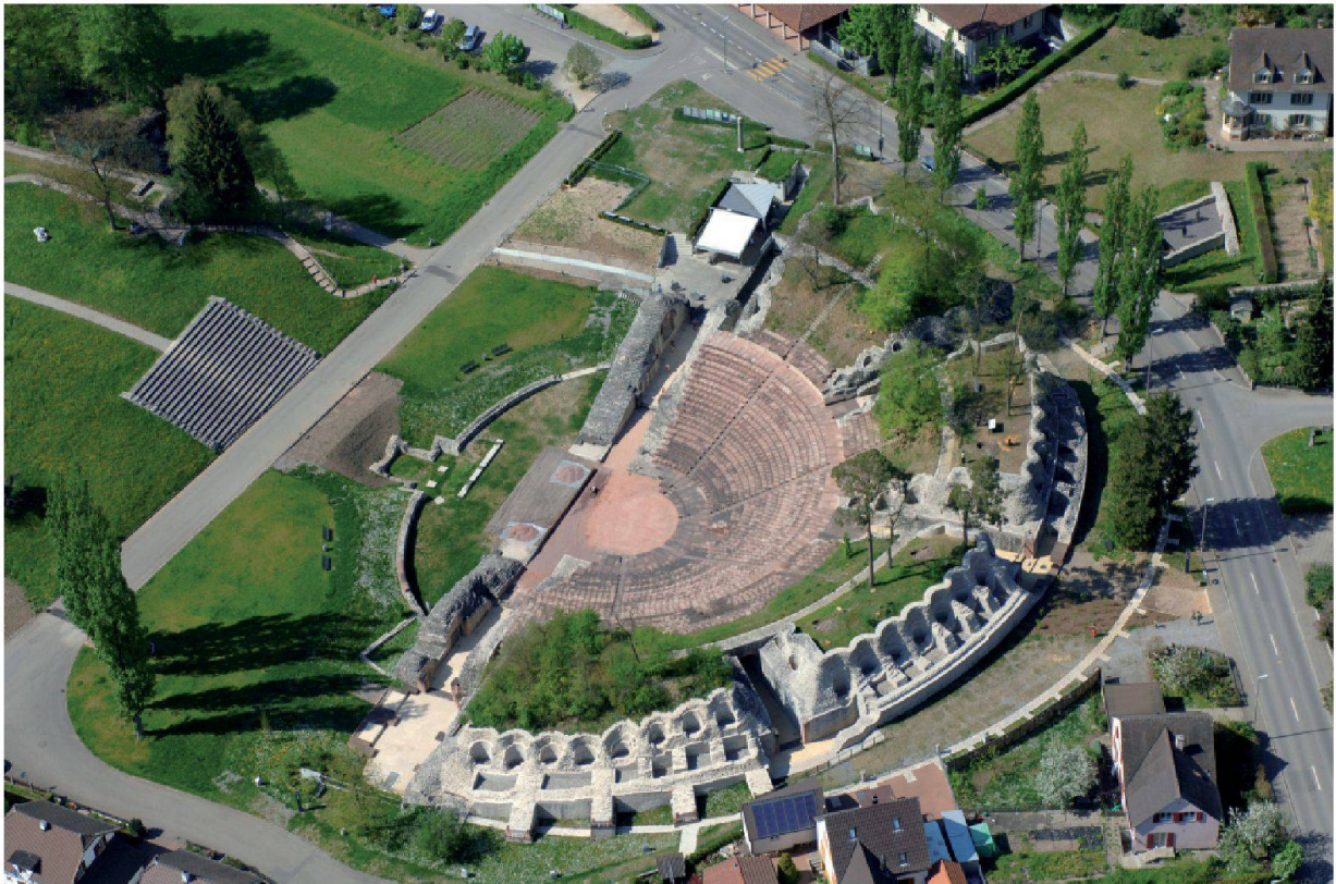
Abb. 12: Augst BL, Luftbildprospektion (Aktennummer 2007.088). Für die Neueröffnung bereit – das römische Theater für einmal aus einem eher ungewohnten Blickwinkel der Einblick gibt in die sogenannten Entlastungsbögen: grosse, halbrunde Hohlkammern, die einst unsichtbar unter den Zuschauerrängen lagen. Im Mittelalter waren neun davon sichtbar. Man hielt sie für Reste von Türmen einer Burg, und dementsprechend hiess die Flur rund um das Theater «Nündürr» (Neun Türme). Von Südosten.
