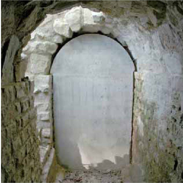
Abb. 47: Füllinsdorf-Wölferhölzli, südliche Peripherie von Augusta Raurica. Restaurierung und Erschliessung eines Abschnitts am Ende der 6,5 km langen Wasserleitung Lausen–Augst. Um Vandalismusschäden zu verhindern, wurde die Fortsetzung des unterirdischen Aquädukts mit einer eingepassten, reversiblen Betonscheibe verschlossen. Links der neue Eingang (Abb. 48).
