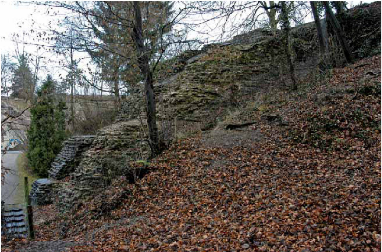
Abb. 51: Augst, Augusta Raurica, Nordhang des Tempelhügels Schönbühl. Erst nach Entfernen von Efeu, Gebüsch und Laub wird der ganze Schaden auf der Maueroberfläche des mächtigen Stützpfilers ersichtlich (Blick von Nordwesten). Seit zwei Generationen ist hier nichts mehr restauriert und unterhalten worden, sodass ein grösseres Sanierungsprojekt auf Augusta Raurica zukommt. Bis Konzept und Mittel bereitstehen, wurde die steinschlaggefährdete Mauerkrone mit einem Sicherheitsnetz abgedeckt (Abb. 52).
