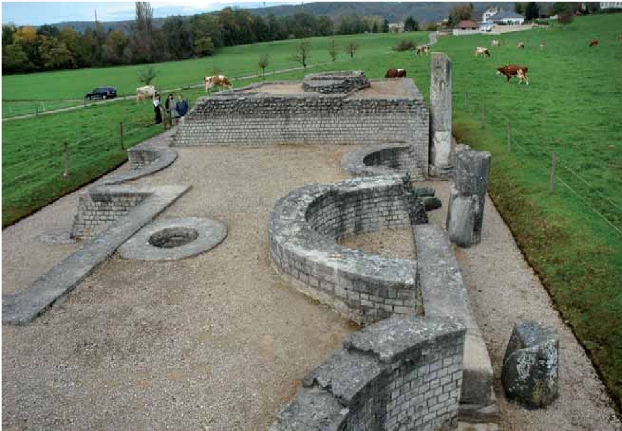
Abb. 63: Augst, Tempelanlage «Grienmatt». Nicht nur etwa 3000 Meter Besucherwege, sondern auch Monumente wie dieses müssen in Augusta Raurica vom Technischen Dienst regelmässig von Unkraut, Efeu, Gras usw. befreit werden. Gerade in der Nachbarschaft römischer Mauern kann unkontrollierter Pflanzenbewuchs zu grossen, z. T. millionenschweren Schäden führen, wie die Erfahrungen mit dem Theater gezeigt haben. Wie lange das mühsam herausgeputzte und gejätete Tempelpodium so pflanzenfrei bleibt wie auf dem Bild, ist ungewiss.
