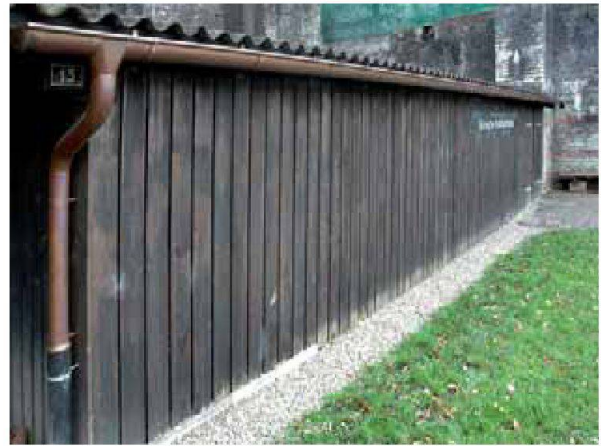
Abb. 61: Augst, Augusta Raurica. Dach der «Römischen Brotbackstube» am Nordfuss des Schönbühls. Eine Regenrinne und eine sanierte Sickeranlage sollen künftig «Überschwemmungen» im Innern des täglich genutzten Workshopgebäudes verhindern.
