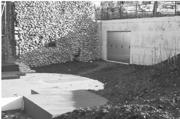
Abb. 29: Augst, Theatersanierung (Grabung 2004.055). Südhalle: In der modernen, die Theaterparzelle gegen Süden begrenzenden Betonstützmauer ist der Kasten der Elektrohauptverteilung untergebracht worden. Die flache Böschung «verdeckt» die in ihrer Ausstattung nicht näher bekannte Abschlussmauer der Südhalle. Blick von Westen.
