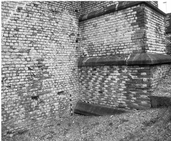
Abb. 11: Augst, Theatersanierung (Grabung 2001.055). Grundlagen zur Erarbeitung eines Auswertungskonzepts. Jüngerer szenisches Theater, Keil 4; Reparatur (?) mit aus Muschelkalk- und Buntsandstein-Handquadern gebildetem Muster, das sich ausschliesslich in dieser Zone beobachten lässt.
