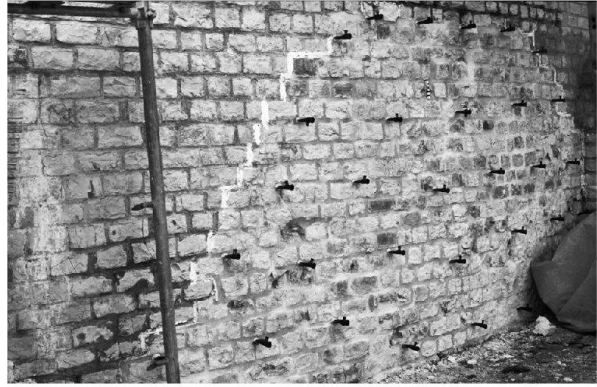
Abb. 44: Augst, Theatersanierung (Grabung 2004.055). Peripheriebereich Keil 4 (MR 58): Nach der Feinsanierung der Mauerschale mit dem rot bemalten Fugenstrich und dem Abdichten möglicher Austrittsöffnungen wurden die Packer zum Einbringen des Injektionsmörtels gesetzt. Der Raster zum Setzen der Packer wurde durch die Erhaltungsgrenzen der antiken Fugmörtelpartien bestimmt. Blick von Süden, im Hintergrund Pfeiler MR 195.
