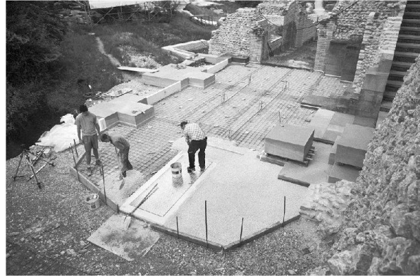
Abb. 28: Augst, Theatersanierung (Grabung 2004.055). Ausgestaltung der Bodenbeläge: Einbringen des hellen Bodenbelags im Bereich der ehemals durch ein Tonnengewölbe überspannten Südhalle. Zur Stabilisierung wird im Bodenbelag ein leichtes Eisennetz eingelegt. Übersicht von Südosten.
