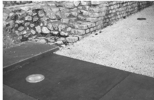
Abb. 30: Augst, Theatersanierung (Grabung 2004.055). Ausgestaltung der Bodenbeläge, Mittelvomitorium: Die Bodenlampen sind in die Bodenbeläge integriert. Blick vom Diazoma-Umgang gegen Nordosten.
