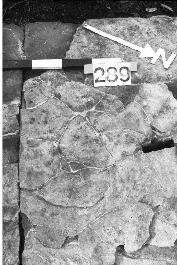
Abb. 32: Augst, Theatersanierung (Grabung 2004.055). Sandsteinschwelle zum Westcarcer (MR 261): Die in vielen Teilstücken abgespaltene Oberfläche des Schwellenquaders aus feinkörnigem Buntsandstein wurde in aufwändiger Feinarbeit restauriert. Die auf der Oberfläche ablesbaren Baudetails können so weiterhin nachvollzogen werden. Im Verlauf der Arbeiten zur Umgebungsgestaltung wird die Sandsteinschwelle mit Erde überschüttet und so zusätzlich vor mechanischer Abrasion geschützt werden.
