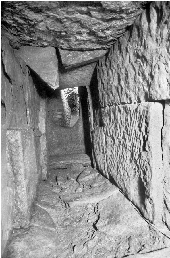
Abb. 18: Augst, Theatersanierung (Grabung 2001.055). Grundlagen zur Erarbeitung eines Auswertungskonzepts. Abwasserkanal auf dem Gelände des Theaters; südlicher Abschnitt mit Gewänden aus grossen Buntsandsteinquadern.
