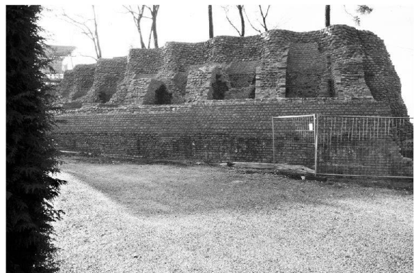
Abb. 42: Augst, Theatersanierung (Grabung 2004.055). Peripherie Keil 3, Blick von Osten auf im Berichtsjahr sanierte Mauerbereiche.
