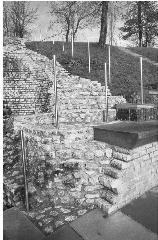
Abb. 26: Augst, Theatersanierung (Grabung 2004.055). Rekonstruktion des Sitzstufenbereichs: Eine Absturzsicherung aus gespannten Drahtseilen fügt sich optisch in den Sitzstufenbereich ein und gewährleistet die Sicherheit der zukünftigen Besucherinnen und Besucher.
