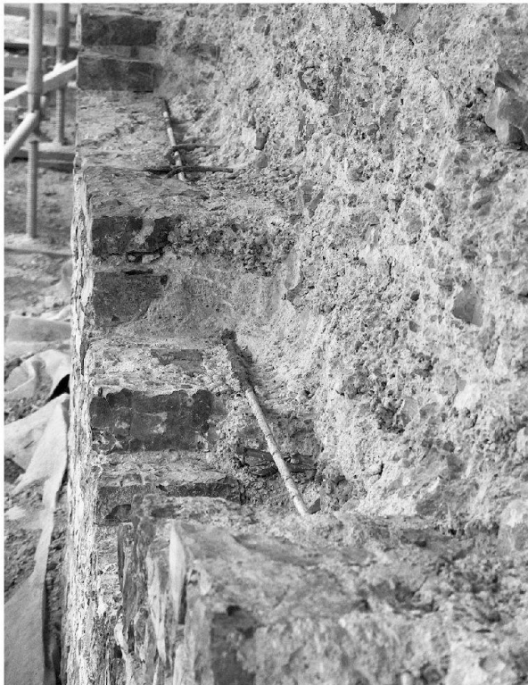
Abb. 33: Augst, Theatersanierung (Grabung 2004.055). Peripheriebereich Keil 3 (MR 58), Arbeitsstand vor Beginn der Aufmauerungsarbeiten: Beispiel einer Eisenarmierung aus den 1940er Jahren.
