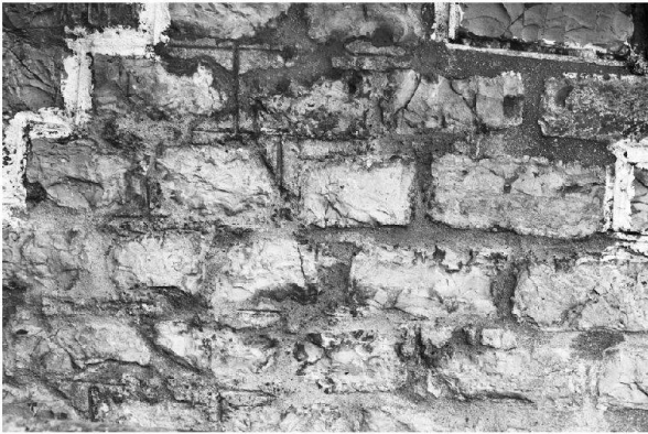
Abb. 45: Augst, Theatersanierung (Grabung 2004.055). Peripheriebereich Keil 4 (MR 58): Ansicht an einen Teil der gesicherten und neu verfugten Mau- erschale.
