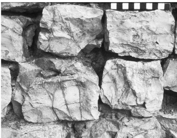
Abb. 41: Augst, Theatersanierung (Grabung 2004.055). Peripheriebereich Keil 3, Mauerinnenschale des Entlastungsbogens MR 131. Die Feinsanierung der Schalenquäderchen ist abgeschlossen und der zum Abdichten verwendete Heissiegelkleber wurde von den Steinen abgezogen; die Mauerpartie ist zum Verfügen bereit.
