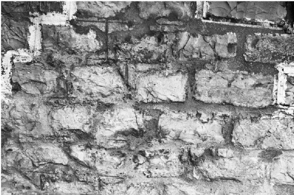
Abb. 45: Augst, Theatersanierung (Grabung 2004.055). Peripheriebereich Keil 4 (MR 58): Ansicht an einen Teil der gesicherten und neu verfugten Mauerschale.
