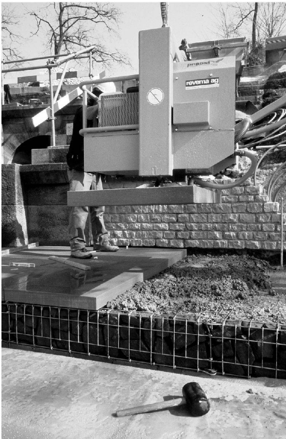
Abb. 22: Augst, Theatersanierung (Grabung 2003.55). Rekonstruktion der Sitzstufen im ersten Rang. Versetzen des Plattenbelags des Diazoma-Umgangs (Umgang der ersten praecinctio). Steinmetz Hanspeter Witschi in Aktion mit dem Vakuum-Hebegerät.
