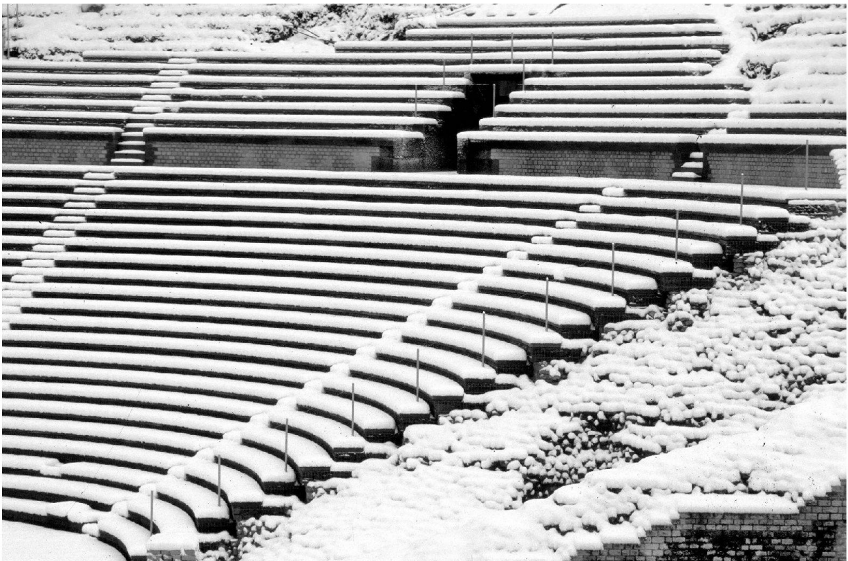
Abb. 27: Augst, Theatersanierung (Grabung 2003.55). Rekonstruktion der Sitzstufen im ersten Rang. Südteil der fertiggestellten Sitzstufenrekonstruktion mit der Mündung des Südost-Vomitoriums.
