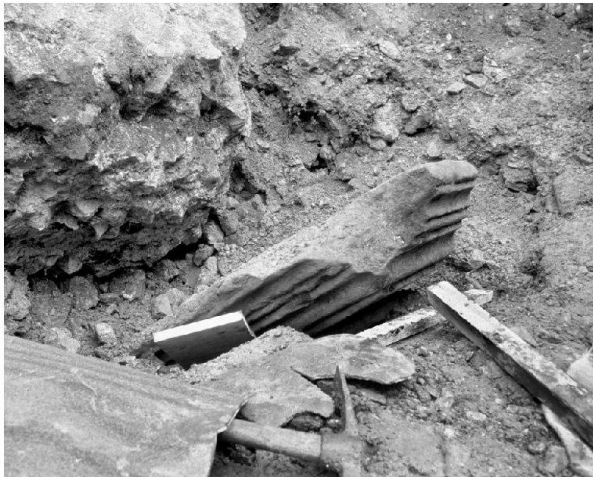
Abb. 11: Augst, Theatersanierung (Grabung 2003.55). Quaderfundamente der südlichen Eingangshalle. An die Fundamentzone reichender Zerstörungsschutt mit Architekturfragment, wohl Teil des Kämpfergesimses der südlichen Eingangshalle.
