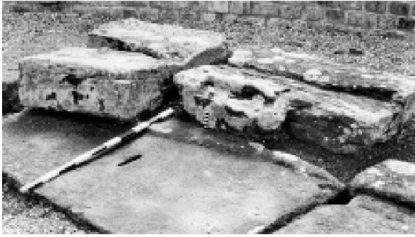
Abb. 2: Augst, Theatersanierung (Grabung 2001.55). Bodenplatten aus Buntsandstein der Orchestra des jüngeren szenischen Theaters. Daran anschliessend zwei Sitzstufenquader der Prohedrie in situ. Beim Quader rechts ist der Ansatz eines ausgehauenen Treppentritts zu erkennen.
