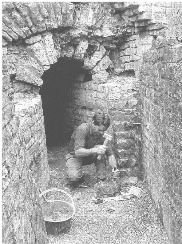
Abb. 44: Augst, Forum/Treppenhaus und Basilika-Stützmauer Nord (Grabung 1910.60). Avelino de Matos Cruz bei Ausbesserungs- und Reparaturarbeiten in der Kloake, welche das Forum unterirdisch entwässerte. Sie wurden nötig, nachdem sich Steine von den beiden Kloakenwänden gelöst und die Besucher gefährdet hatten.
