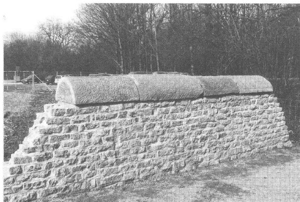
Abb. 43: Augst, Osttorareal (Grabung 1998, S. 6). Dieser Mauerabschnitt (MR 1) veranschaulicht heute die einstige Umfassung des monumentalen Grabrundbaus vor dem Osttor von Augusta Raurica. Die Teilrekonstruktion ist in der vermuteten Brüstungshöhe ausgeführt. Von den vier halbzyklindrischen Abdecksteinen aus Buntsandstein sind die mittleren beiden Originale, zum Schutz flankiert von zwei nachgehauenen Elementen (von Ost).
