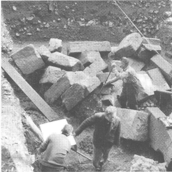
Abb. 19 Augst-«Bötme» (Grabung 1969.52). Die verstürzten Brückenquader in situ. Blick gegen Osten .
