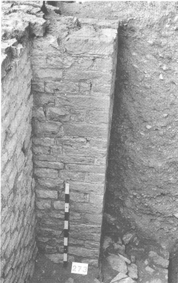
Abb. 19 Augst BL, Osttor. Grabung 1991.52. Ansicht an den Stützpfiler 34. Blick gegen Westen. An den unverwitterten Stellen ist der steinsichtige Verputz mit Fugenstrich zu erkennen.
