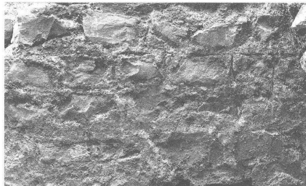
Abb. 6 Augst BL, Grabung 1990.69. Detail mit dem gut erhaltenen Fugenstrich an der Portikusmauer (MR 2) der jüngeren Phase der 2. Steinbauperiode. Blick nach Osten.
