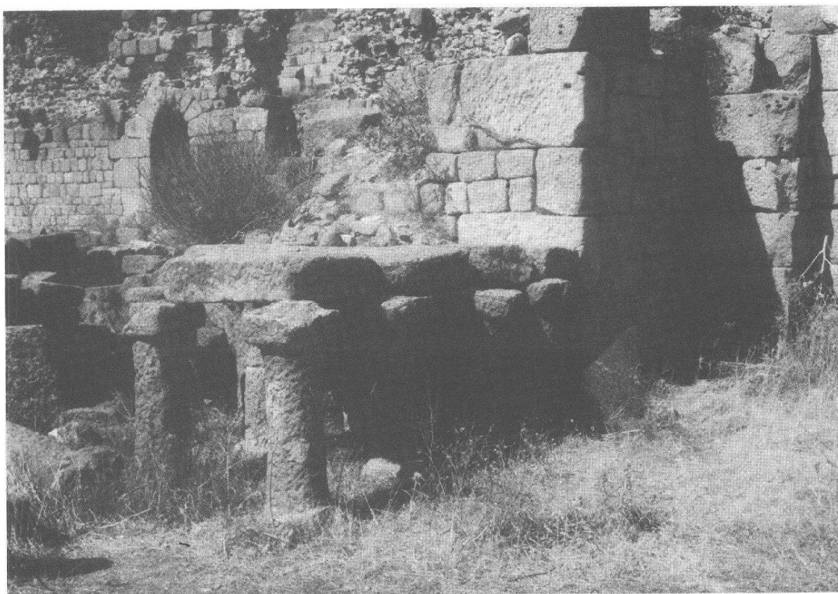
Abb. 7 Pergamon, Hypokaustempfeiler aus den römischen Bädern auf der Gymnasiumsterrasse.
