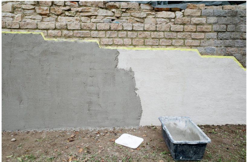
Abb. 14: Augst BL, Amphitheater (Monumentenrestaurierung 905.2022.01). Aufbringen der oberen Putzlage; hier in noch nicht abgeglättetem Zustand.
