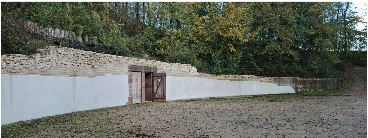
Abb. 15: Augst BL, Amphitheater (Monumentenrestaurierung 905.2022.01). Fertiggestellte nördliche Podiumsmauer nach dem Aufbringen des Kalkputzes. Im ersten Moment erscheint der Putz noch recht hell, er wird aber unter dem Einfluss der Witterung rasch dunkler werden und sich besser ins Gesamtbild integrieren.
