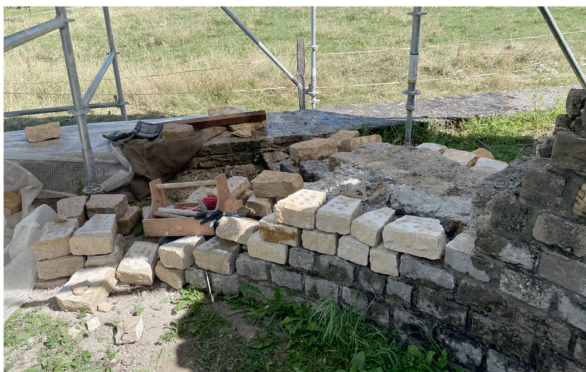
Abb. 10: Augst BL, Grienmatt (Monumentenrestaurierung 904.2022.01). Vorbereitung der Kalkstein-Handquader für die Erneuerung der Mauerschalen bei den Altrestaurierungen aus den frühen 1960er-Jahren.
