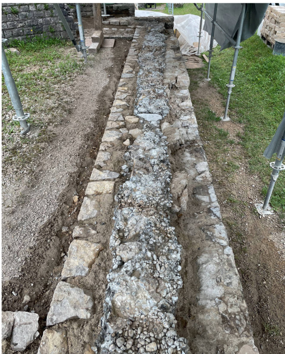
Abb. 8: Augst BL, Grienmatt (Monumentenrestaurierung 904.2022.01). Zustand nach Abbau der Altrestaurierungen aus den frühen 1960er-Jahren bis auf das Niveau des soliden Mauerwerks. Der heterogene Aufbau mit einer lockeren Zementbetonschicht im Inneren und mit stark sandigem Zementmörtel im Schalenmauerwerk ist deutlich sichtbar.
