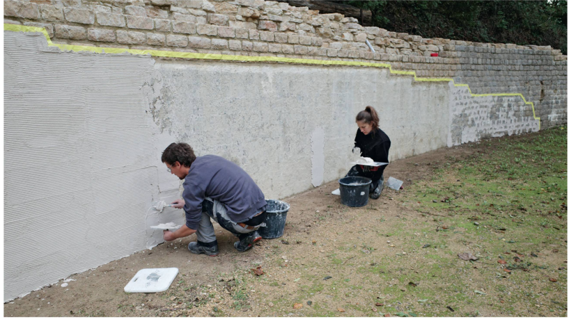
Abb. 13: Augst BL, Amphitheater (Monumentenrestaurierung 905.2022.01). Chiara Marcon und Simon Friz beim Aufbringen der ersten Kalkputzlage (Bio-Einbettmörtel) auf das rekonstruierte Mauerwerk aus Zementsteinen.
