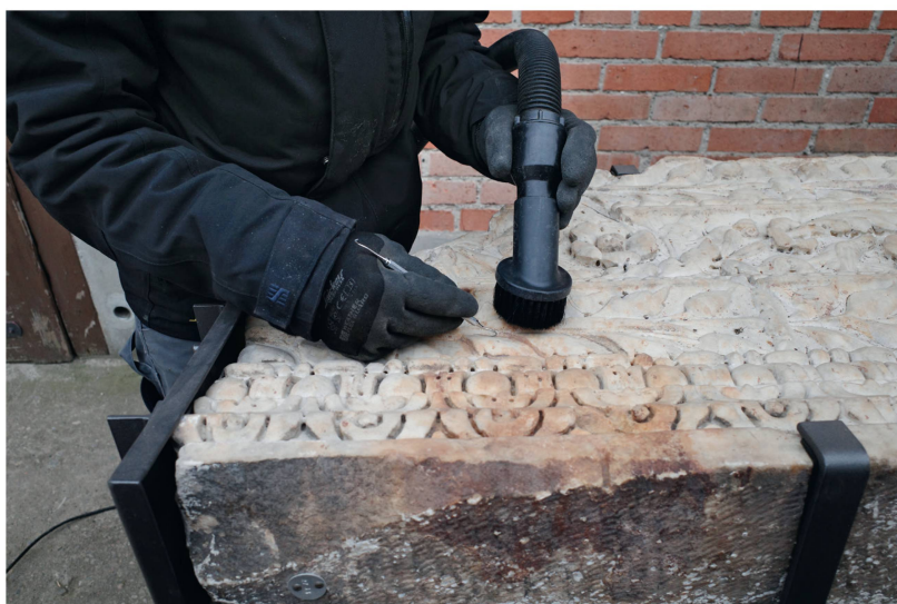
Abb. 17: Augst BL, Grosssteinlager Schwarzacker (Monumentenrestaurierung ohne Nr.). Reinigung des Türgewändes aus weissem Marmor vom Tempel auf Schönbühl mit Staubsauger und Skalpell. Nebst den üblichen Verschmutzungen durch Staub und Mikroorganismen mussten hier auch zahlreiche Silikonreste, die beim Erstellen früherer Abformungen haften geblieben waren, aus den Ritzen und Vertiefungen entfernt werden.
