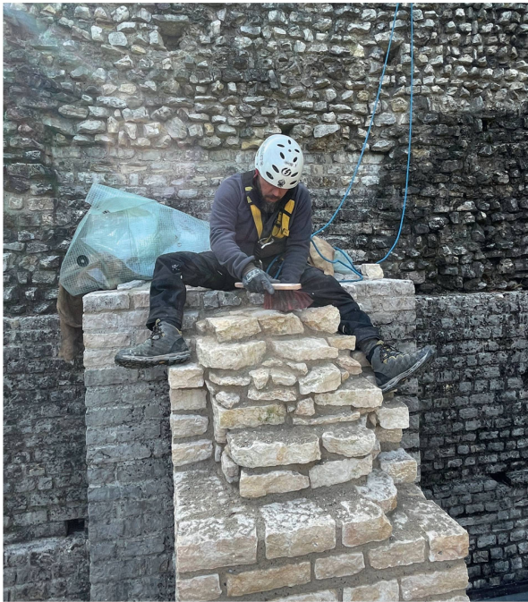
Abb. 4: Augst BL, Schönbühl-Brotbackstube (Monumentenrestaurierung 903.2022.01). Westlicher Stützpfiler der Terrassenmauer auf der Nordseite des Schönbühlabhanges. Gian-Titus Heinzelmann bei der Fertigstellung der erneuerten Aufmauerung. Aufgrund der exponierten Lage mussten die Arbeiten am Seil gesichert vorgenommen werden.
