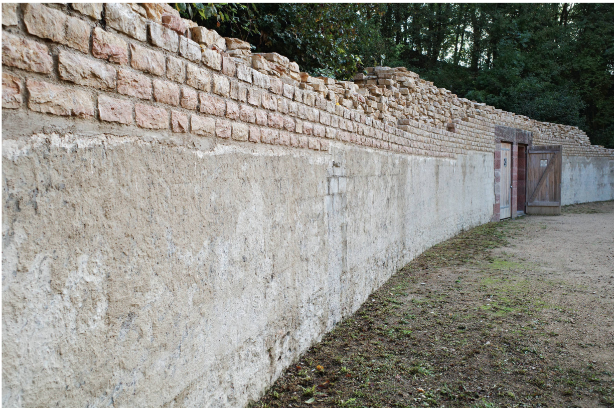
Abb. 12: Augst BL, Amphitheater (Monumentenrestaurierung 905.2022.01). Zustand der nördlichen Podiumsmauer mit 2021 erneuerten oberen Mauerbereichen und aus Zementsteinen rekonstruierter Mauerschale aus den späten 1980er-Jahren. Der untere Bereich wurde 2022 mit einem diffusionsfähigen Verputz aus Kalkmörtel versehen, der den Wassertransport aus den hinter dem Mauerwerk liegenden Hangzonen ermöglichen soll.
