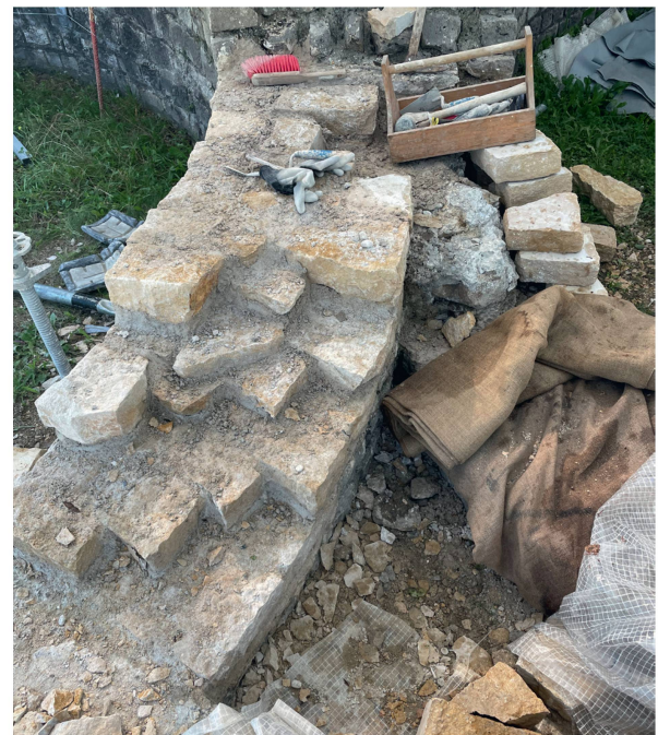
Abb. 11: Augst BL, Grienmatt (Monumentenrestaurierung 904.2022.01). Erneuerte Überkronung im Bereich der Entlastungsbögen auf der Nordseite.
