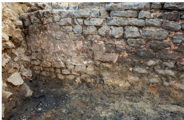
Abb. 13: Kaiseraugst AG, Dorfstrasse 39 (Grabung 2022.001). Detail des Terrazzomörtelverputzes am Nordhaupt von Mauer MR Pos 92.
