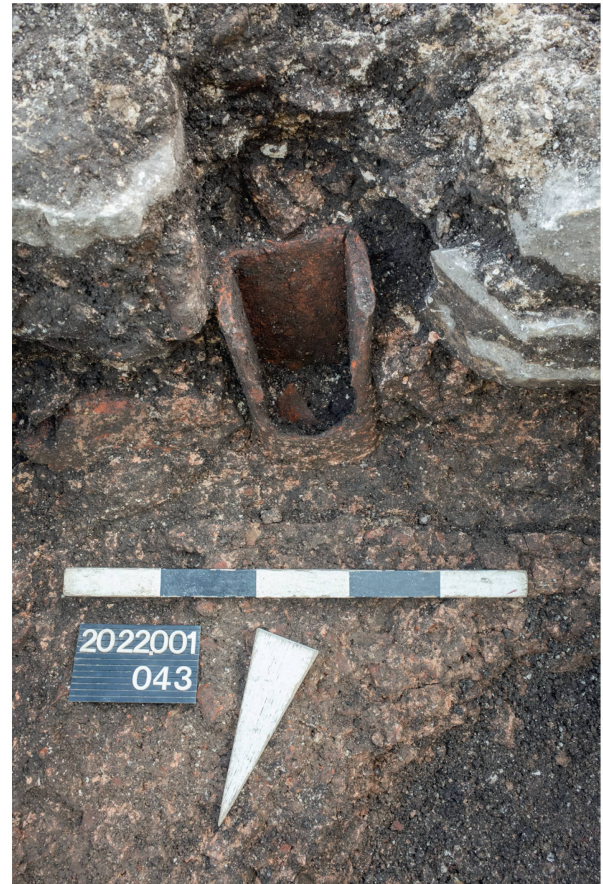
Abb. 29: Kaiseraugst AG, Dorfstrasse 39 (Grabung 2022.001). Detail des spätantiken Mörtelgussbodens Pos 40 und des tubulus Pos 131 in situ in Mauer MR Pos 79 in Gebäude 3.
