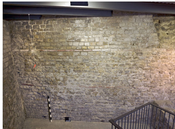
Abb. 32: Augst BL, Taberna (Intervention 2022.060). Mauer MR 1C in der modern überdachten und für Besucher zugänglichen Taberna. Blick nach Nordosten.
