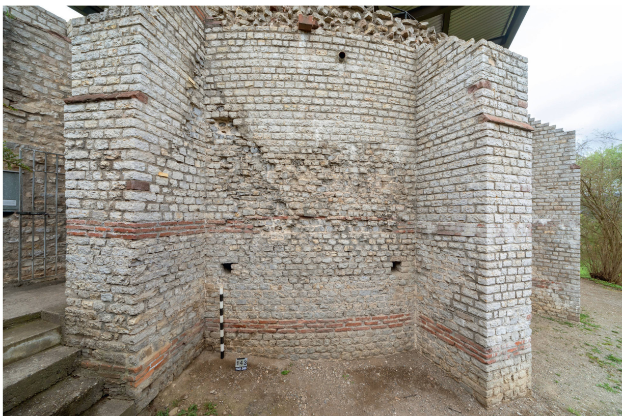
Abb. 13: Augst BL, Curia (Intervention 2021.066). Aussenseite, Blick von Südosten an den Abschnitt MR 1g. Das zwischen den Stützpfeilern MR 8 und MR 7 befindliche zugemauerte Fenster (Fenster 3) (Beilage 2B,8) ist nicht nur dank der Baufugen, sondern auch durch das qualitativ schlechtere Steinmaterial deutlich ablesbar. Vermutlich wurden nach dem Brand die noch brauchbaren, aber durch die Hitze geschwächten Handquader wiederverwendet.
