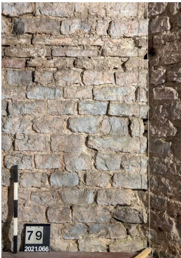
Abb. 18: Augst BL, Curia (Intervention 2021.066). Innenraum, Blick von Norden auf den unteren Mauerbereich von MR 1m und an die Verbindung zur rückwärtigen Curiamauer MR 9. Die leicht abgekippten Steine und die zum Teil hohl gebliebenen, zum Teil vermörtelten Ausbrüche zeigen, dass MR 9 nachträglich in MR 1m eingezahnt worden ist. Bei dem hierfür nötigen Ausbruch wurden verschiedene Handquader des Schalenmauerwerks von MR 1m herausgerissen oder verschoben.
