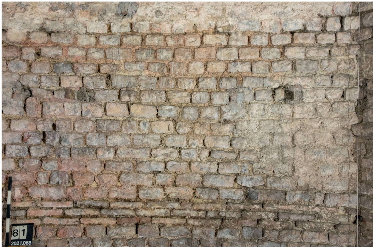
Abb. 20: Augst BL, Curia (Intervention 2021.066). Innenraum, Blick von Norden an den Mauerbereich oberhalb des Ziegelbands in Abschnitt MR 1m mit Eck-situation zu MR 9 (rechts im Bild). Die Struktur und die Steingrößen weisen darauf hin, dass hier verschiedene Veränderungen am Schalenmauerwerk stattgefunden haben. In der linken Bildhälfte in der Mitte ist die breite Mörtelfuge der ursprünglichen Bauphase von MR 1 zu erkennen (Beilage 1,21). Gegen Süden (rechts) bricht diese Fuge ab und die Quader des Schalenmauerwerks sind kleiner und mit mehr Mörtel versetzt (Beilage 1,27), noch weiter rechts knicken die Fugen leicht nach oben ab und die Steinhäupter sind mit Mörtel verschmiert (Beilage 1,39.40). Im Bereich der unteren sechs Steinlagen stösst die Mauerschale von MR 1m an MR 9 an, danach bilden die beiden Schalen einen Eckverband.
