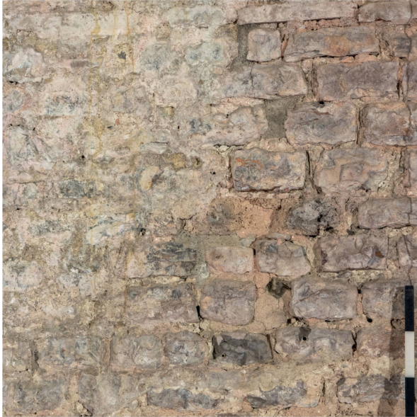
Abb. 14: Augst BL, Curia (Intervention 2021.066). Innenraum, Blick von Südwesten auf die südöstliche untere Ecke der Fensterzumauerung (Fenster 2) in Abschnitt MR 1e (Beilage 1,32). Eine Schneidfuge und der Deckstein aus Quelltuff lassen das über zwei Steinlagen reichende antik zugemauerte Balkenloch erkennen (Beilage 1,11).
