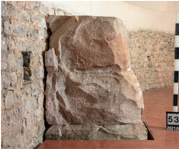
Abb. 27: Augst BL, Curia (Intervention 2021.066). Innenraum, Blick von Südwesten an den nördlichen Sandsteinstützpfiler MR 11 (vgl. Abb. 5; Beilage 1,22). Gut zu erkennen ist die breite Fuge zwischen Pfeiler und hinten durchlaufender Tambourmauer MR 1, links daneben ein offenes Balkenloch (Beilage 1,5).
