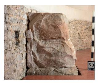
Abb. 27: Augst BL, Curia (Intervention 2021.066). Innenraum, Blick von Südwesten an den nördlichen Sandsteinstützpfeiler MR 11 (vgl. Abb. 5; Beilage 1,22). Gut zu erkennen ist die breite Fuge zwischen Pfeiler und hinten durchlaufender Tambourmauer MR 1, links daneben ein offenes Balkenloch (Beilage 1,5).
