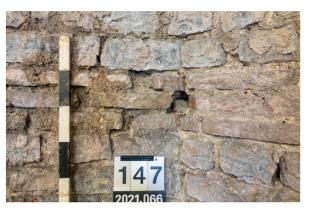
Abb. 19: Augst BL, Curia (Intervention 2021.066). Innenraum, Detailaufnahme des Eckverhältnisses der Ziegelbänder von MR 1m und MR 9. Der Ziegel der mittleren Ziegellage von MR 1m (links) wurde partiell ausgebrochen, um an dieser Stelle das Ziegelband von MR 9 (rechts) einzahnen zu können. Wie der Mörtelstopfen an der Ausbruchstelle zeigt, kam es, zumindest auf Ebene der Mauerschalen, aber trotzdem nicht zu einem richtigen Verband, sodass MR 9 hier an MR 1m anstösst.
