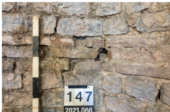
Abb. 19: Augst BL, Curia (Intervention 2021.066). Innenraum, Detailaufnahme des Eckverhältnisses der Ziegelbänder von MR 1m und MR 9. Der Ziegel der mittleren Ziegellage von MR 1m (links) wurde partiell ausgebrochen, um an dieser Stelle das Ziegelband von MR 9 (rechts) einzazuhnen zu können. Wie der Mörtelstopfen an der Ausbruchstelle zeigt, kam es, zumindest auf Ebene der Mauerchalen, aber trotzdem nicht zu einem richtigen Verband, sodass MR 9 hier an MR 1m anstösst.
