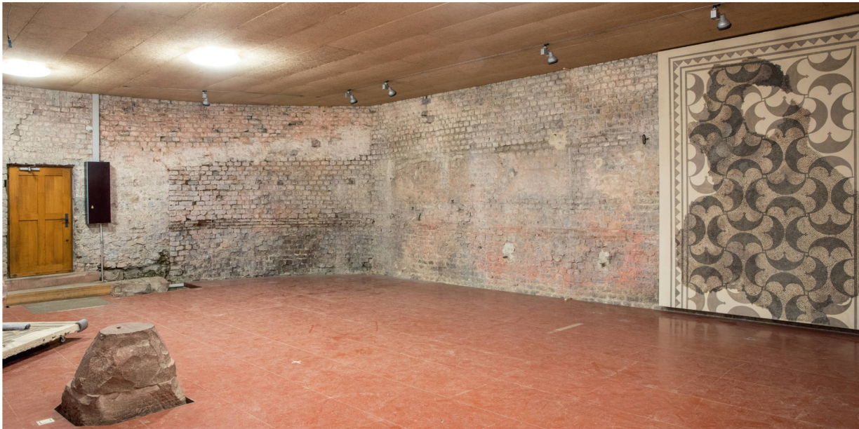
Abb. 33: Augst BL, Curia (Intervention 2021.066). Innenraum, Blick von Norden auf Abschnitt MR 1m der Tambourmauer (linke Bildhälfte) und die rückwärtige Curiamauer MR 9 (rechte Bildhälfte) mit dem grossen, im Moment noch an der Wand befestigten Bodenmosaik aus Insulae 41/47. Links ist die vertikal verlaufende Baufuge der Zumauerung des ursprünglichen Kellerzugangs erkennbar, am linken Bildrand die moderne, 1961 ins antike Mauerwerk eingebrochene Türe in Abschnitt MR 1h. Im Vordergrund links die Reste des zentralen Sandsteinstützpfilers MR 12 mit den durch die Hitze des Brands abgeplatzten Quaderecken. Das von der Fuge der Türzumauerung wegführende mörtelverschmierte Band in der oberen Zone von MR 1m (Beilage 1,38) zieht ziemlich genau an derselben Stelle an die rückwärtige Curiamauer MR 9, an der die beiden Mauerzüge nicht miteinander im Verband errichtet wurden, sondern die Reparatur von MR 1 an die Aufstockung von MR 9 reicht (Beilage 2A,13). Oberhalb davon bilden die Tambourmauer und die rückwärtige Curiamauer einen sauberen Verband und sind nachweislich gleichzeitig entstanden. Die Rosafärbung an den Maueroberflächen stammt nicht etwa von Verputzresten aus Ziegelschrotmörtel, sondern ist auf den Befall durch Actinobakterien (Gattung Rubrobacter) zurückzuführen.
