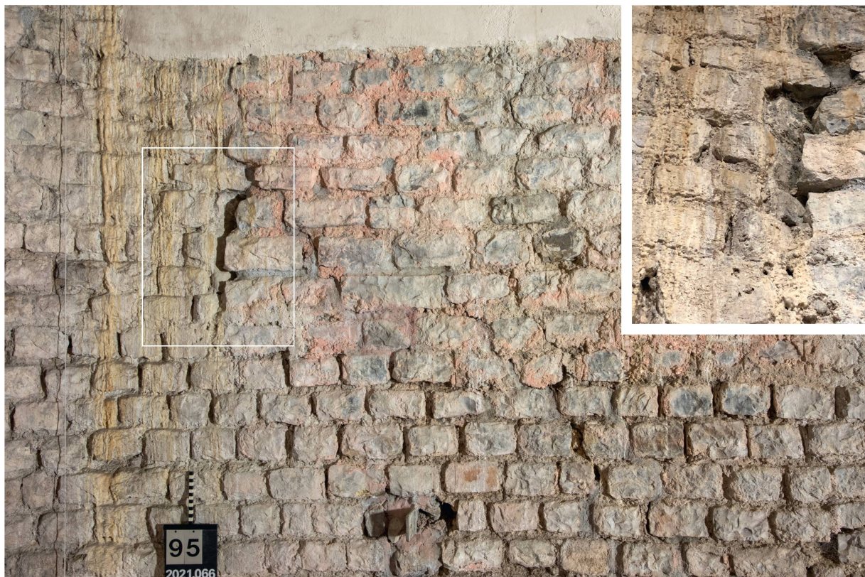
Abb. 28: Augst BL, Curia (Intervention 2021.066). Innenraum, Blick von Osten an die vertikale fünfstrigige Baufuge mit der abgelenkten, schräg hinter die Tambourmauer MR 1 ziehenden jüngeren Basilicastützmauer im Abschnitt MR 1a (Beilage 1,41). Baubefund im Mauerkontext und Detailauszug (Bildausschnitt rechts) mit der umbiegenden Basilicastützmauer und dem nachträglich daran angefügten oberen Bereich der Tambourmauer MR 1.
