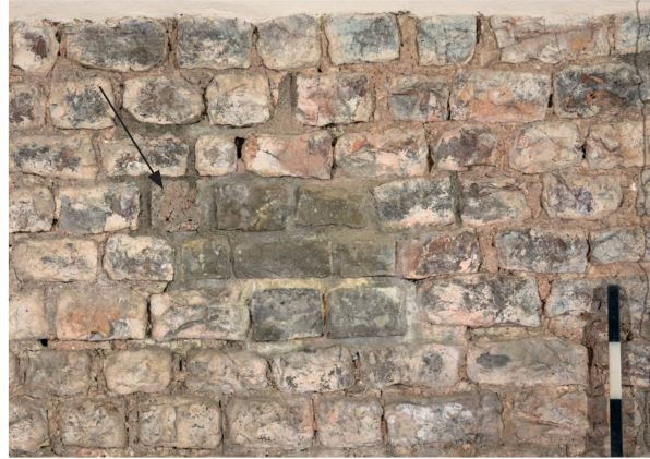
Abb. 15: Augst BL, Curia (Intervention 2021.066). Innenraum, das modern zugemauerte Balkenloch in Abschnitt MR 1d (Beilage 1,9) kann in Übereinstimmung mit den anderen modern zugemauerten Balkenlöchern in diesem Mauerbereich (Beilage 1,7–9) dank des Rests des Tuffdecksteins, der Höhenlage und der Position im Verhältnis zum nächst liegenden Stützpfeiler eindeutig identifiziert werden (Pfeil). Tuffsteine finden sich bei der Curia ausschliesslich in Verwendung als Decksteine für Balkenlöcher. Die moderne Zumauerung der Balkenlöcher erfolgte vermutlich im Zusammenhang mit den Restaurierungsarbeiten der frühen 1960er-Jahre.
