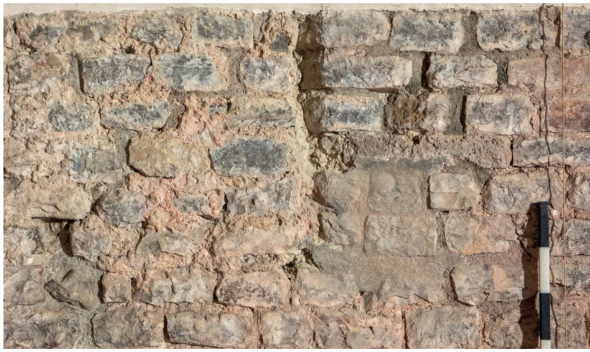
Abb. 10: Augst BL, Curia (Intervention 2021.066). Innenraum, Blick auf das östliche Fenstergewände (Fenster 1) und die sekundäre Zumauerung (links im Bild) in Abschnitt MR 1c. Die drei noch erhaltenen, schräg in einem Winkel von 135° abgehenden Gewändequader sind nach Entfernen der modernen Zementrestaurierung deutlich sichtbar. Unmittelbar rechts davon, direkt unterhalb des Gewändes gibt sich ein modern zugemauertes antikes Balkenloch durch den langen Deckstein aus Quelltuff zu erkennen (Beilage 1,7).
