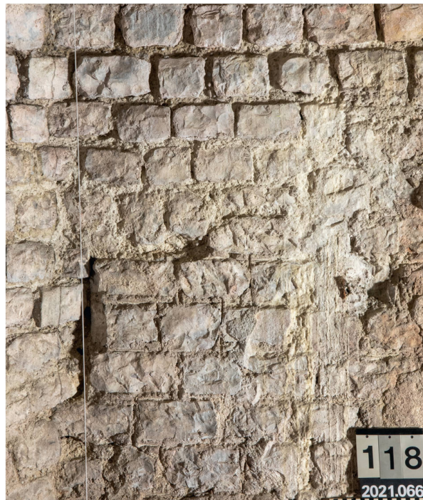
Abb. 23: Augst BL, Curia (Intervention 2021.066). Innenraum, Blick an die rückwärtige Curiamauer MR 9 beim Anstoss an die Tambourmauer MR 1m. In der unteren Bildhälfte links drei übereinanderliegende Handquader (Beilage 2A,9), die offenbar einst an einen Werksteinquader anstießen, dessen Ecke sich beim untersten Quader in Form eines Negativabdrucks im Kalkmörtel erhalten hat. Oberhalb ist über vier Steinlagen eine Reparatur im Schalenmauerwerk erkennbar, die vom Entfernen eines weiteren Werksteinquaders stammen könnte.
