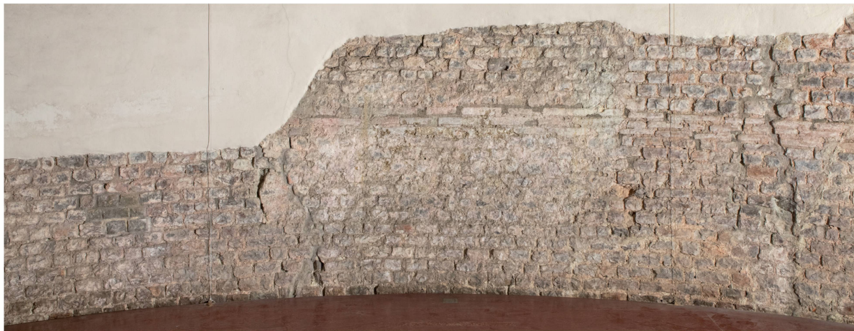
Abb. 9: Augst BL, Curia (Intervention 2021.066). Innenraum, Blick von Westen auf die antik zugemauerte Fensteröffnung (Fenster 2) im zentralen Mauerabschnitt MR 1e. Die vertikal gespannten Schnüre markieren die Mittelachsen der aussen gelegenen Stützpfeiler MR 5 und MR 6.
