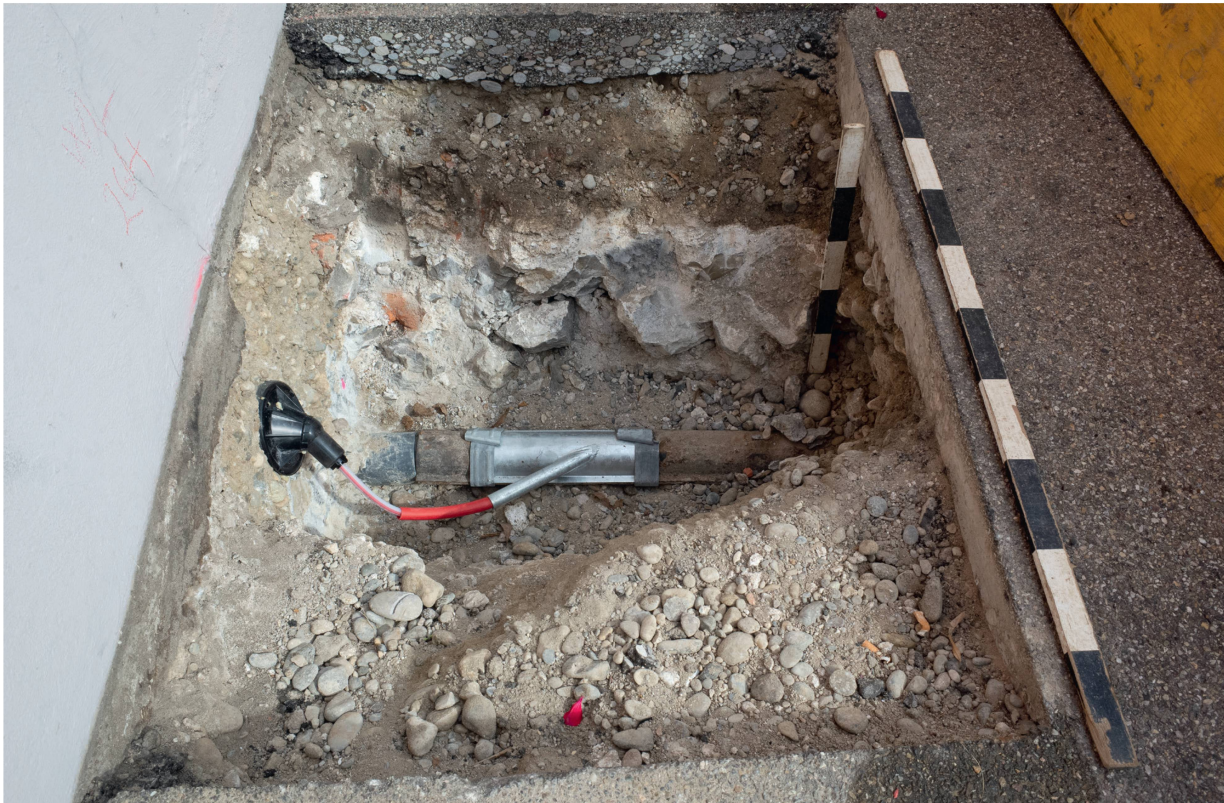
Abb. 67: Kaiseraugst AG, Swisscom Glasfasernetz (Grabung 2021.010). Feld 5 mit der im Jahre 1972 verlegten, die Kastellmauer schneidenden Leitung. Blick von Westen.
