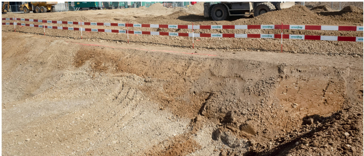
Abb. 6: Kaiseraugst AG, Neubau DSM (Grabung 2021.003). Blick von Süden an die östliche Baugrubenböschung mit Lehmsenke.
