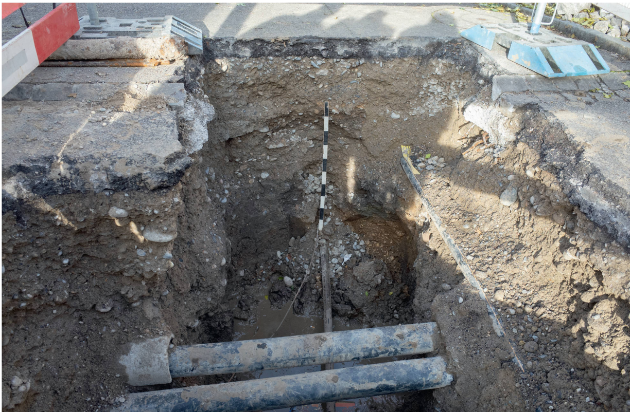
Abb. 68: Kaiseraugst AG, Swisscom Glasfasernetz (Grabung 2021.010). Feld 8 von Süden. Unter modernen Strassenkoffierungen sind dunkelbraune Schichten (links vom Massstab) und helleres, mit Kalksteinabschlägen durchsetztes Material (rechts) erkennbar.
