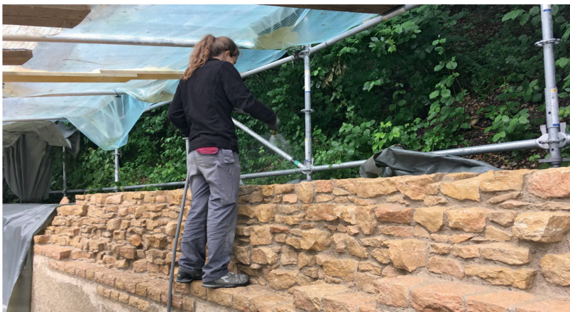
Abb. 18: Augst BL, Amphitheater (Monumentenrestaurierung 905.2020.01). Podiumsmauer, Ersatz von Vormauerungen und Abdichtung, Südwest-Abschnitt. Der neu aufgebaute obere Mauerbereich nach Abschluss der Arbeiten. Die Mauerkrone ist nun besser gegen eindringendes Sickerwasser geschützt und dank der Gestaltung als Steilabbruch wird das Niederschlagswasser effizienter an den Mauerfuß abgeleitet.
