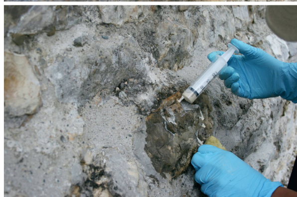
Abb. 31: Kaiseraugst AG, Gewerbehaus Schmidmatt (Monumentenrestaurierung 917.2020.01). Konservierung von Mauerzügen ausserhalb des Schutzbaus. Neukonservierung der originalen Mauerzüge: Nach Reinigung mit Schwamm und Bürste wurden die losen Teile der Handquader wieder angeklebt und die Risse mit einem sehr flüssigen Kalkmörtel gefüllt. Erst im Anschluss an diese Konsolidierung des Steinmaterials konnte der umliegende Portlandzement, sofern er nicht zu tief in die Fugen gepresst worden war, entfernt und durch einen weichen und diffusionsfähigeren Kalkmörtel ersetzt werden.
