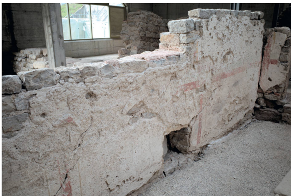
Abb. 36: Kaiseraugst AG, Gewerbehaus Schmidmatt (Monumentenrestaurierung 917.2020.02). Konservierung von Wandmalerei in situ (Couloir Raum 5). Die Westwand (MR 21) von Raum 5 vor Beginn der Konservierungsarbeiten. Trotz der zahlreichen Risse war der Interventionsaufwand erheblich geringer als erwartet, da bei den früheren Konservierungsarbeiten in den 1990er-Jahren deutlich weniger Acrylmörtel zum Einsatz gekommen war.
