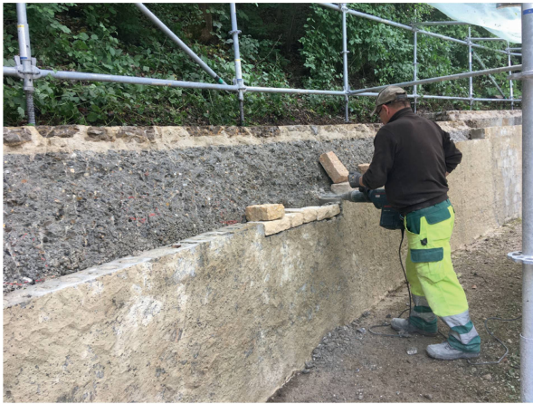
Abb. 16: Augst BL, Amphitheater (Monumentenrestaurierung 905.2020.01). Podiumsmauer, Ersatz von Vormauerungen und Abdichtung, Südwest-Abschnitt. Beginn des Aufbaus der neuen Mauerschale mit Jurakalk aus dem Laufental.
