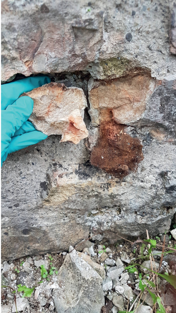
Abb. 30: Kaiseraugst AG, Gewerbehaus Schmidmatt (Monumentenrestaurierung 917.2020.01). Konservierung von Mauerzügen ausserhalb des Schutzbaus. Typisches Schadensbild: Als Folge der früheren Restaurierungen, bei denen die Fugen mit hartem Portlandzement ausgetrichen wurden, sind die Handquader aus Kalkstein zerrissen und zersplittert; Wurzelwerk der Pioniervegetation hat sich in diesen Rissen angesiedelt und akkumuliert Feuchtigkeit in den Quadern, die im Winter zu Frostsprengungen führt.
