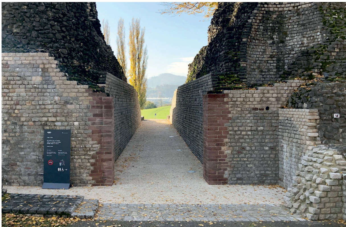
Abb. 43: Augst BL, Theater (Monumentenrestaurierung 924.2020.02). Umfassende Reinigungsarbeiten in den vomitoria und den aditus. Erscheinungsbild des Nordost-Vomitoriums nach vollständiger Reinigung mit Heissdampf. Der Boden ist von Erde und Moos befreit und lässt die Niederschläge wieder effizient versickern; die Wände sind von den schwärzlichen, die Feuchtigkeit speichernden Biopatina-Krusten befreit, haben aber dank der schonenden Reinigung ihre natürliche Patina bewahrt.
