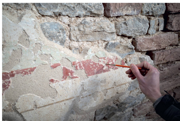
Abb. 34: Kaiseraugst AG, Gewerbehaus Schmidmatt (Monumentenrestaurierung 917.2020.02). Konservierung von Wandmalerei in situ (Couloir Raum 5). Erneuerung der Anböschungen am Putz von MR 26 (Westseite) und Anbringen von Retuschen. Nachdem die hohl liegenden Stellen gesichert worden waren, konnten die alten Böschungen aus Plextolmörtel entfernt werden. Der in vielen Fällen sehr fragile Zustand machte an den Rändern grössere Nachinjektionen nötig. Im Anschluss erfolgte eine Reinigung von dem an der Oberfläche der Risse ausgetretenen Kalk, bevor die Flächen mit gebührender Zurückhaltung nachretuschiert werden konnten.
