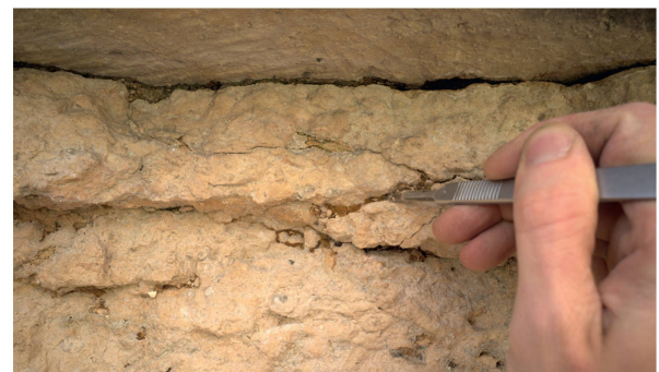
Abb. 7: Augst BL, Schönbühl (Monumentenrestaurierung 903.2020.02). Restaurierung der Stereobatenquader und der SE-Ecke des Tempelpodiums. Südliches in situ erhaltenes Quaderfundament: Reinigung von Rissen mit dem Skalpell. Die eingestete Vegetation führt mit ihrem Wurzelwachstum zur Ausdehnung der Mikrorisse und letztlich zum Absprengen ganzer Steinfragmente.
