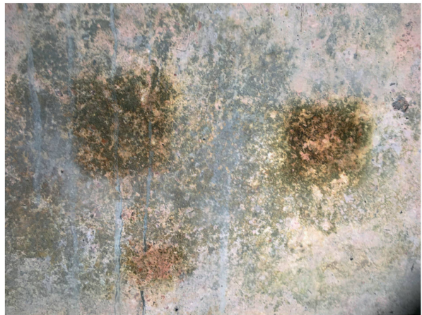
Abb. 27: Kaiseraugst AG, Rheinthermen (Monumentenrestaurierung 916.2020.01). Umfassende Reinigungsarbeiten. Testflächen zur Entfernung der Algen und der stark anhaftenden Schmutzschicht an der Oberfläche der Beckenwände; gut erkennbar sind die Zementschlieren aus der Bauzeit der Betondecke.
