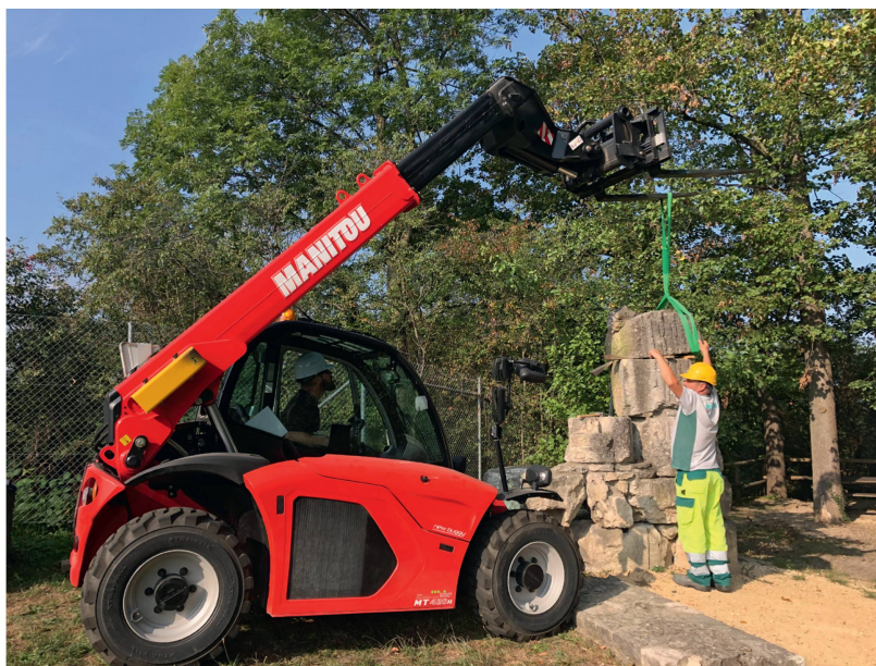
Abb. 11: Augst BL, Schönbühl (Monumentenrestaurierung 903.2020.03). Abbau der Architekturprobe aus dem 19. Jahrhundert. Der Einsatz des Teleskopladern und die Handhabung der fragilen Architekturstücke aus Kalkstein verlangen einiges an Fingerspitzengefühl. Dank dem umsichtigen Einsatz von Steinbildhauer Gian-Titus Heinzelmann und Maurer Mladen Puklin ging der Abbau ohne Unfälle oder Schäden an den wertvollen Bauteilen über die Bühne.
