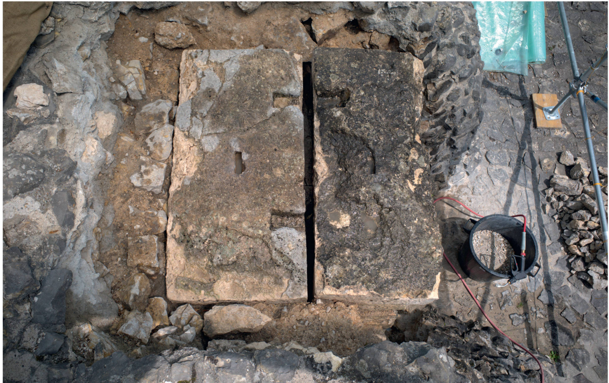
Abb. 5: Augst BL, Schönbühl (Monumentenrestaurierung 903.2020.02). Restaurierung der Stereobatenquader und der SE-Ecke des Tempelpodiums (Aufsicht). Südliches in situ erhaltenes Quaderfundament, Zustand vor Beginn der Arbeiten: Durch Einfluss von Wasser und Frost hatte der fragile Kalkstein bereits begonnen, an verschiedenen Orten abzubrockeln. Zusätzliche mechanische Belastungen durch Begehung verschärften das Problem.
