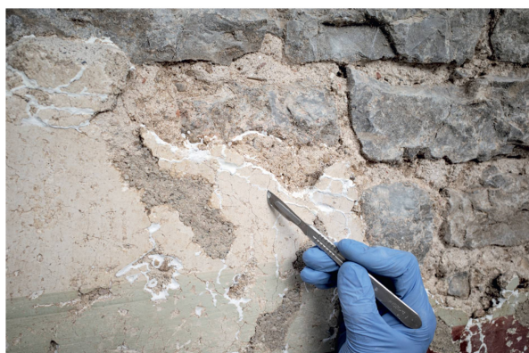
Abb. 34: Kaiseraugst AG, Gewerbehaus Schmidmatt (Monumentenrestaurierung 917.2020.02). Konservierung von Wandmalerei in situ (Couloir Raum 5). Erneuerung der Anböschungen am Putz von MR 26 (Westseite) und Anbringen von Retuschen. Nachdem die hohl liegenden Stellen gesichert worden waren, konnten die alten Böschungen aus Plextolmörtel entfernt werden. Der in vielen Fällen sehr fragile Zustand machte an den Rändern grössere Nachinjektionen nötig. Im Anschluss erfolgte eine Reinigung von dem an der Oberfläche der Risse ausgetretenen Kalk, bevor die Flächen mit gebührender Zurückhaltung nachretuschiert werden konnten.
