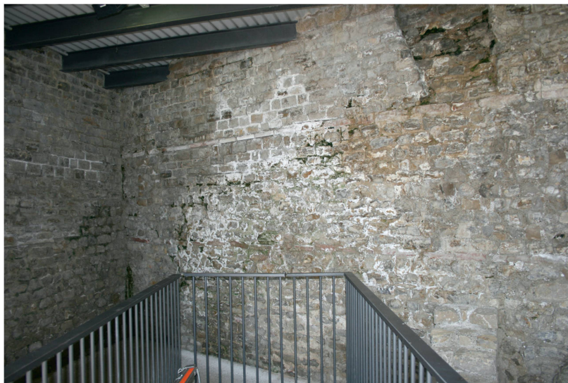
Abb. 20: Augst BL, Taberna (Monumentenrestaurierung 907.2020.01). Reinigung von Algen und starken Salzausblühungen. An der hangseitigen Tabernenrückwand kam es im erneut sehr trockenen Sommer 2020 zu grossflächigen Chloridausblühungen und starker Algenbildung.
