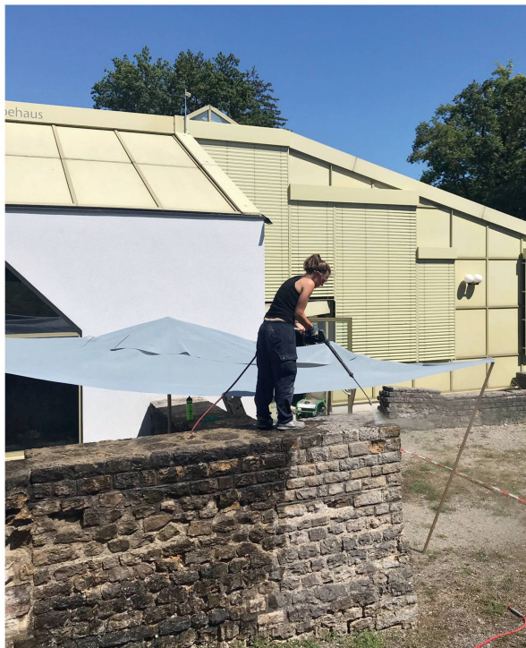
Abb. 28: Kaiseraugst AG, Gewerbehaus Schmidmatt (Monumentenrestaurierung 917.2020.01). Konservierung von Mauerzügen ausserhalb des Schutzbaus. Restauratorin Chiara Marcon, die unser Team seit Juni 2020 verstärkt, bei der Reinigung des Mauerwerks mit sanftem Druck und Heissdampf.
