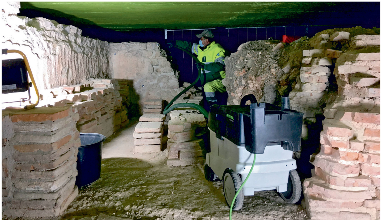
Abb. 23: Kaiseraugst AG, Rheinthermen (Monumentenrestaurierung 916.2020.01). Umfassende Reinigungsarbeiten. Absaugen der Sediment- und Zementstaubschichten auf den Mauern aus Kalkstein und auf den Böden.
