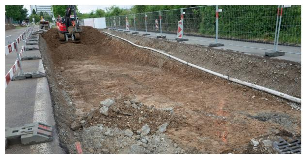
Abb. 51: Kaiseraugst AG, Personenunterführung Landstrasse (Grabung 2020.008). Blick von Osten auf die Baustelle. Der Aushub der Nordrampe der Unterführung ist im Gange. Rechts im Vordergrund sind die Reste der Tonröhrenleitung zu erkennen.
