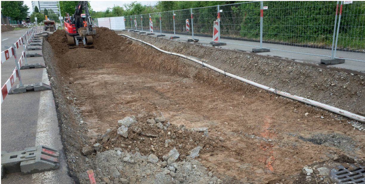
Abb. 51: Kaiseraugst AG, Personenunterführung Landstrasse (Grabung 2020.008). Blick von Osten auf die Baustelle. Der Aushub der Nordrampe der Unterführung ist im Gange. Rechts im Vordergrund sind die Reste der Tonröhrenleitung zu erkennen.
