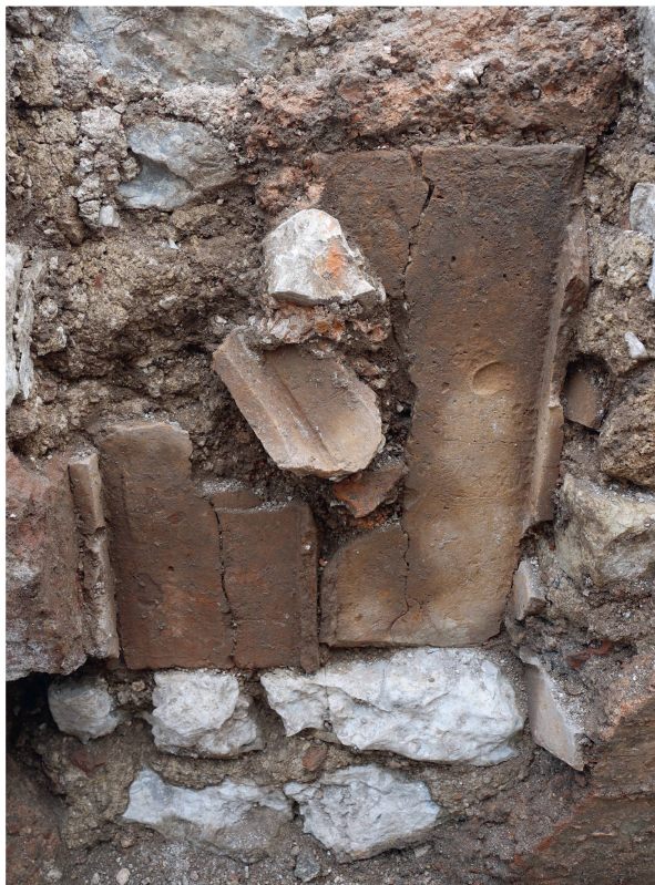
Abb. 39: Augst BL, Giebenacherstrasse 26 (Grabung 2018.055). Unterer Teil eines Abgaskanals im beheizten Gang 4.
