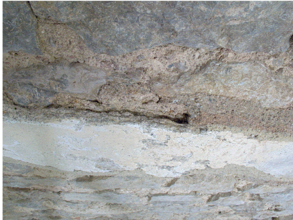
Abb. 22: Kaiseraugst AG, Schmidmatt (Monumentenrestaurierung 917.2019.01). Wandmalerei in Korridor 5. Links: Durch Spannungen und starke Temperaturschwankungen vom Kalksteinmauerwerk abgelöste originale Verputzplatten mit weissgrundiger Malerei. Situation nach partieller Entfernung der Anböschungen aus Plextolmörtel. Rechts: Anjo Weichbrodt bei der Sicherung von originalen Kalkfugen mittels in Ethanol gelöstem Nanokalk.
