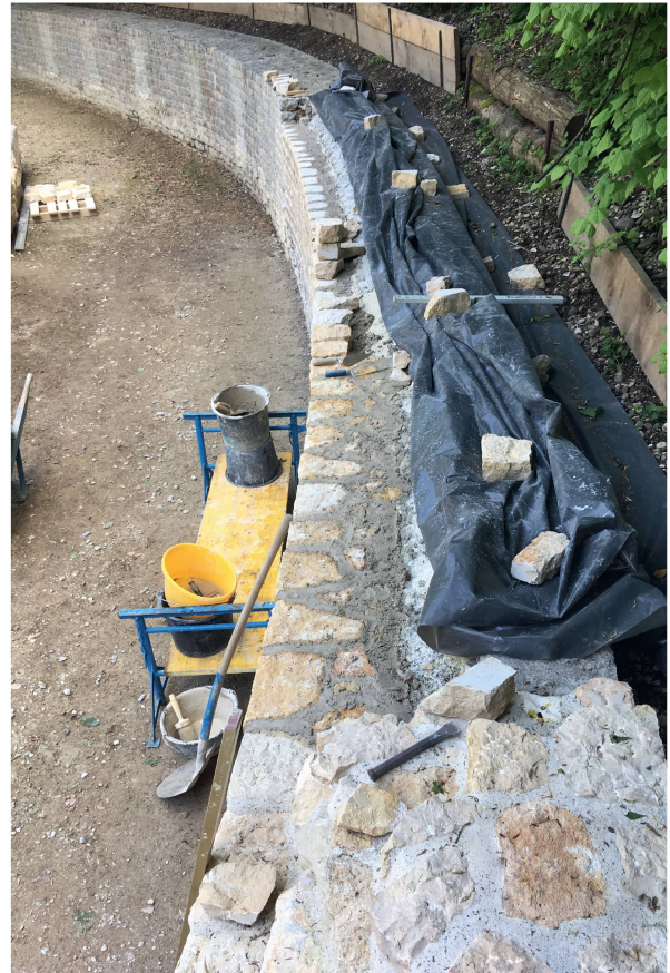
Abb. 9: Augst BL, Amphitheater (Monumentenrestaurierung 905.2019.01). Restaurierung und Erneuerung der rekonstruierten Podiumsmauer. Links und rechts: Maurer Mladen Puklin beim Erstellen der neuen Mauerabdeckung.
