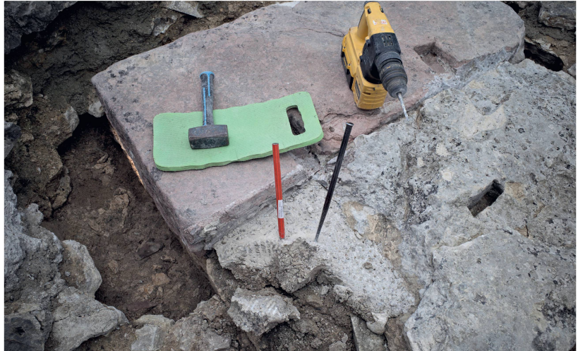
Abb. 2: Augst BL, Schönbühl (Monumentenrestaurierung 903.2019.01). Konservierung eines originalen Stereobatenquaders des Schönbühltempels. Entfernen der viel zu harten, schädigenden alten Zementergänzungen; eine heikle und zeitaufwendige Arbeit.
