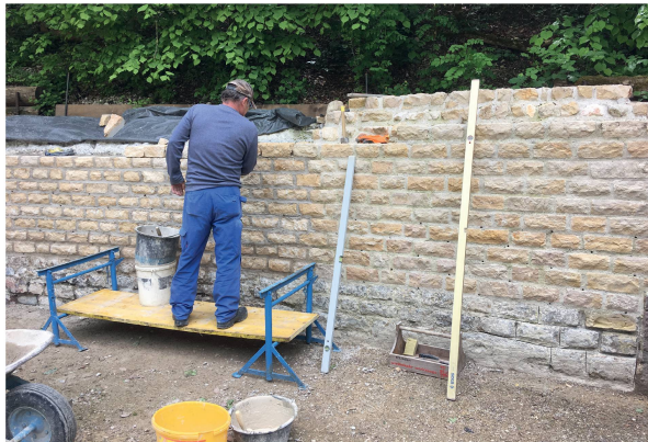
Abb. 9: Augst BL, Amphitheater (Monumentenrestaurierung 905.2019.01). Restaurierung und Erneuerung der rekonstruierten Podiumsmauer. Links und rechts: Maurer Mladen Puklin beim Erstellen der neuen Mauerabdeckung.
