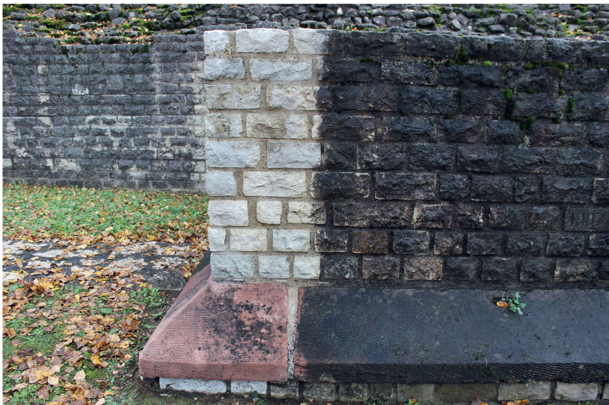
Abb. 26: Augst BL, Theater (Monumentenrestaurierung 924.2019.01). Nordseite beim Eingang zum Nordost-Vomitorium. Reinigungsversuche mit Heissdampf: Gereinigte Eckzone des Stützpfilers mit angrenzender dunkler, ungereinigter Fläche.
