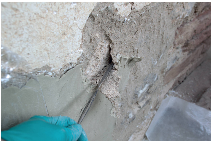
Abb. 21: Kaiseraugst AG, Schmidmatt (Monumentenrestaurierung 917.2019.01). Wandmalerei in Korridor 5. Abschälen des durch den Alkohol angelösten synthetischen Mörtels.
