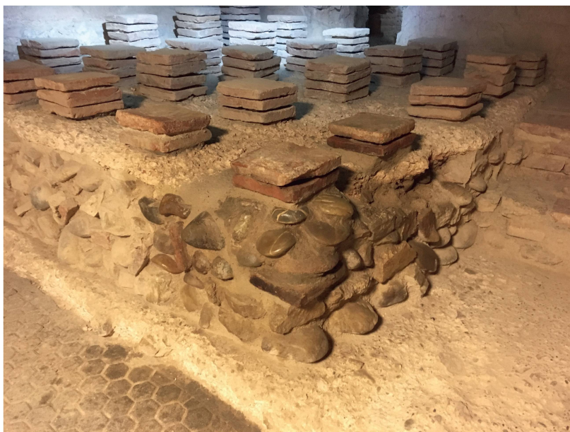
Abb. 19: Kaiseraugst AG, Rheinthermen (Monumentenrestaurierung 916.2019.01). Reparierter Zustand mit wiederversetztem Eckstück.
