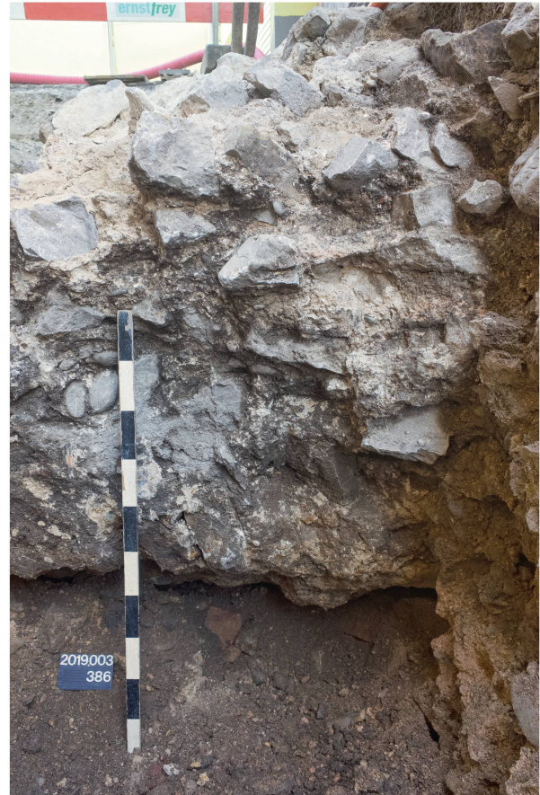
Abb. 14: Kaiseraugst AG, Bolingerhaus (Grabung 2019.003). Ansicht auf das infolge Beraubung der Mauerschale freiliegende Gussmauerwerk des Osthauptes der Kastellmauer mit deutlich erkennbarer Unterminierung im Fundamentbereich. Norden ist rechts.
