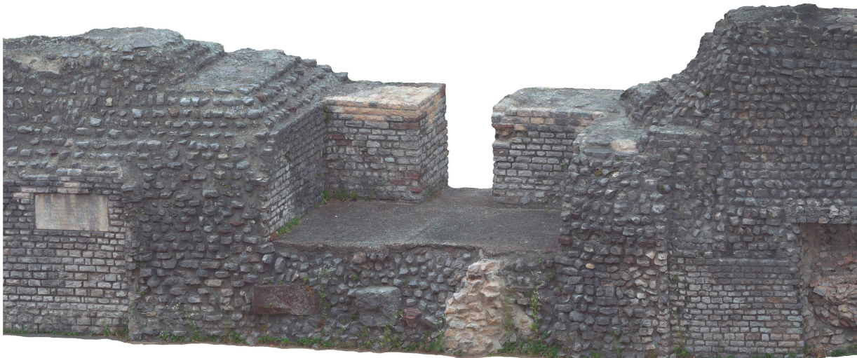
Abb. 38: Kaiseraugst AG, Dokumentation Kastellmauer (Grabung 2019.009). Auszug aus dem 3-D-Modell mit Turm 2 von Süden aus gesehen. Detaillierte Mauersichten können aus dem Modell generiert werden und dienen als massstabsgetreue Fotos für die weitere Dokumentation im Rahmen der Sanierung.
