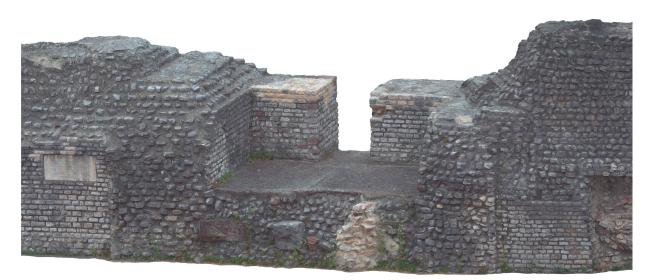
Abb. 38: Kaiseraugst AG, Dokumentation Kastellmauer (Grabung 2019.009). Auszug aus dem 3-D-Modell mit Turm 2 von Süden aus gesehen. Detaillierte Maueransichten können aus dem Modell generiert werden und dienen als massstabsgetreue Fotos für die weitere Dokumentation im Rahmen der Sanierung.
