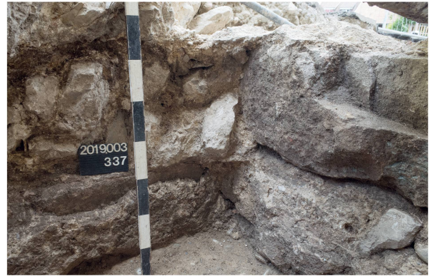
Abb. 21: Kaiseraugst AG, Bolingerhaus (Grabung 2019.003). Blick von Südosten auf das Detail des Eckverbands zwischen der Kastellmauer (links) und Turm 12 (rechts) im Fundamentbereich.
