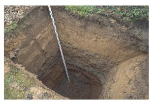
Abb. 3: Kaiseraugst AG, Sondierungen Reservoirleitung Im Liner (Begleitung 2019.001). Blick von Westen in eine der Sondierungen: Der rezente Humus überlagert den anstehenden Lehm. Darunter ist der stark mit Eisenoxidausfällungen durchzogene anstehende Schotter zu erkennen.
