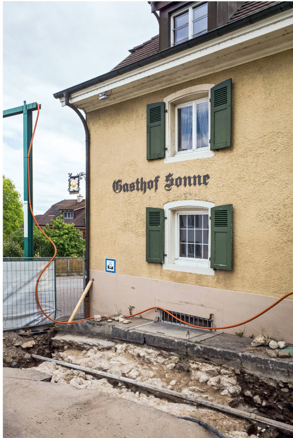
Abb. 20: Kaiseraugst AG, Bolingerhaus (Grabung 2019.003). Blick von Südwesten auf den Gasthof Sonne und auf den Turm 12 unmittelbar unter dem Trottoir.
