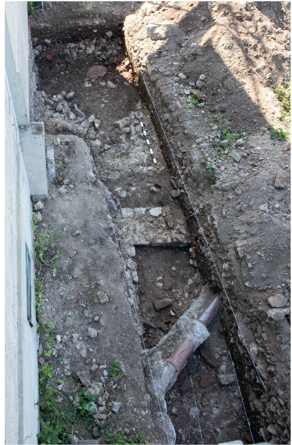
Abb. 64: Augst BL, Gasleitung Giebenacherstrasse 26 (Baubegleitung 2019.070). Blick von Osten in den westlichen Abschnitt des Leitungsgrabens. Im Mittelgrund die Mauerecke MR 1 (links)/MR 2 und im Hintergrund der stark gestörte Mörtelgussboden der Eingangshalle 5.
