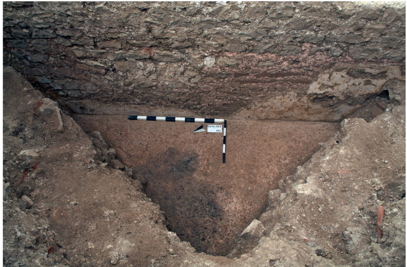
Abb. 45: Augst BL, Sondierungen N2 (Grabung 2019.052). Sondierung 9: Sehr gut erhaltener Terrazzoboden mit Brandspuren. Mauer MR 1 ist im unteren Bereich unterfangen worden, was u. a. anhand der Leistenziegellagen und des Ziegelschrotmörtels ersichtlich ist. Zudem sind noch Reste eines weissen Verputzes vorhanden. Blick von Osten.
