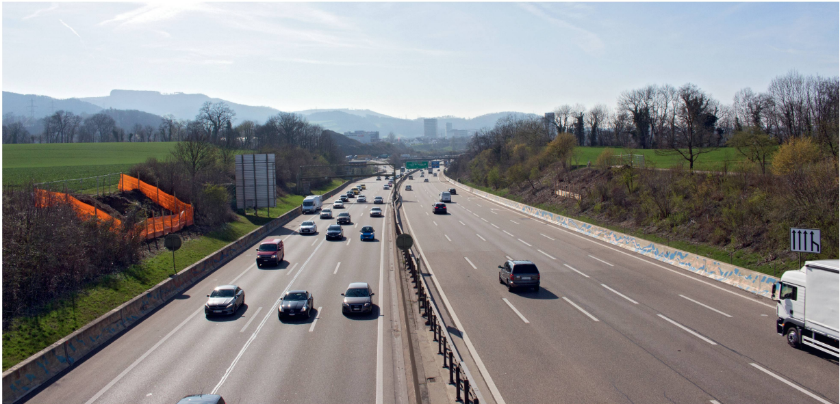
Abb. 20: Augst BL, Sondierungen N2 (Grabung 2019.052). Blick von Osten auf die Nationalstrasse N2 und die Sondierungen 1 (links) und 7 (rechts) noch vor der Grabungstätigkeit. Die Böschungen waren eine technische Herausforderung.
