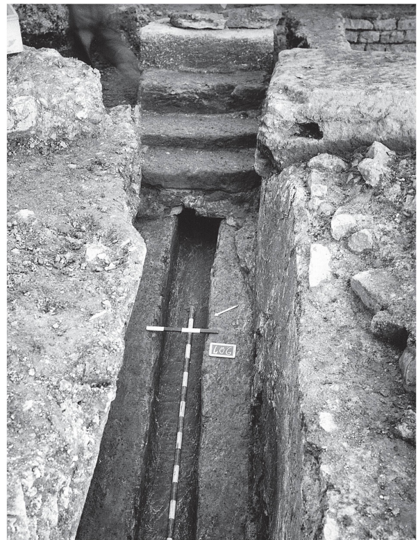
Abb. 43: Augst BL, Grabung N2/A3 (Grabung 1966.055). Treppe zu einem unterirdischen Gang, unter dessen Boden aus Steinplatten der Abwasserkanal eines kleinen Bads verläuft. Die Abdeckplatten sind auf dem Bild bereits entfernt. Blick von Nordwesten.
