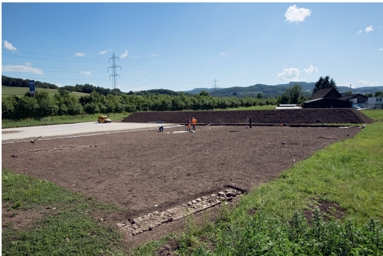
Abb. 14: Augst BL, Sammlungszentrum (Baubegleitung 2019.051). Dokumentationsarbeiten der römischen Befunde, während im Hintergrund bereits mit der Kiesaufschüttung für das Bauprojekt begonnen wird. Im Vordergrund Mauer MR 31. Blick von Nordosten.
