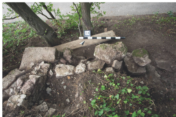
Abb. 62: Augst BL, Kastelen Gartengestaltung (Baubegleitung 2019.068). Blick von Südosten auf die Mauern MR 1 (rechts) und MR 2 (links), bevor das lose Steinmaterial entfernt wurde.
