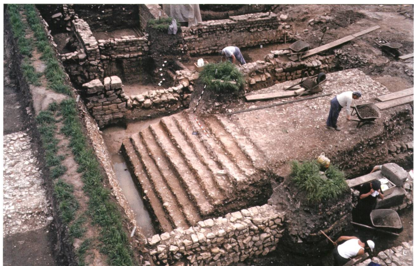
Abb. 15: Augusta Raurica. Schnitt durch die immer wieder aufgeköfferten Kieskörper der Venusstrasse (Grabung 1969.053). Blick von Süden. Am unteren Bildrand befindet sich die Portikus von Insula 50; die baulichen Strukturen gegenüber liegen in Insula 44.
