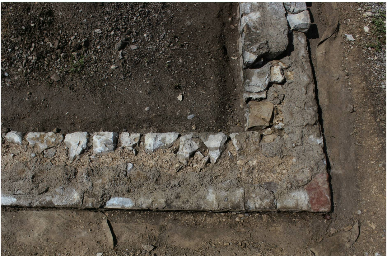
Abb. 35: Augst BL, Vierecktempel Schönbühl II (Intervention 2017.062). Römerzeitliche Mauerlage aus Kalkbruchsteinen und Buntsandsteinen in beigefarbenem Kalkmörtel. Rechts oben Altrestaurierung 1957.061 mit kleineren, regelmässigeren Kalkquadern und dem mit grauem Zementmörtel verfüllten Mauerkern. Unten am Bildrand markieren Eternitplättchen die Grenze zwischen römischem Originalmauerwerk und den Aufmauerungen von 1957. Blick von Südosten.
